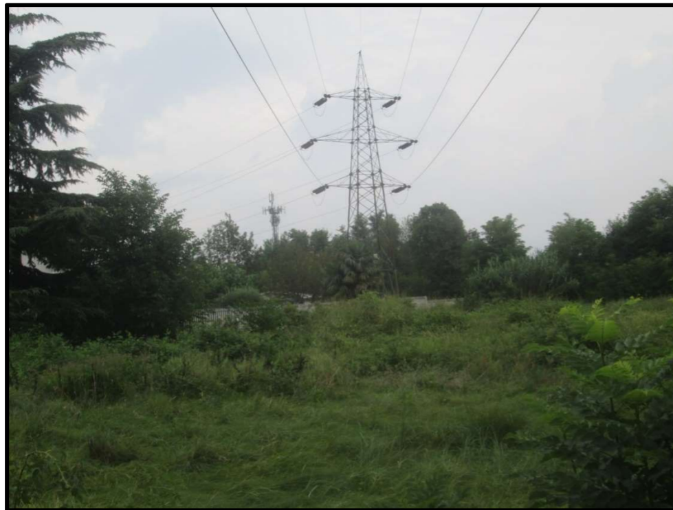
Traliccio n. 147 da prato tra le abitazioni, a monte di Via Vittorio Alfieri – circa da sud – S. Gillio
