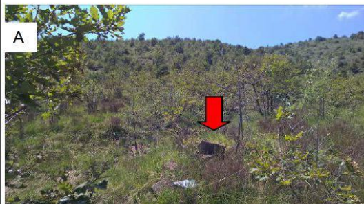
A – Area di fondazione nuovo sostegno. Con substrato roccioso affiorante e qualche blocco lapideo.
