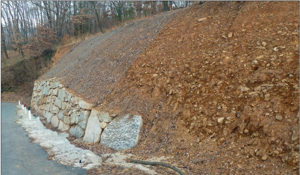
Figura 3.5.4/4 – Strada di accesso al Campo Sportivo – Zona nuovo sostegno n. 99
