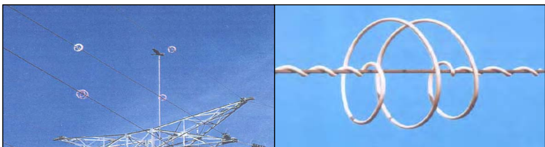
Figura 9.b: Spirali utilizzate come Sistemi di Dissuasione Visiva e Sonora sui Conduttori di un Elettrodotta ad Alta Tensione
