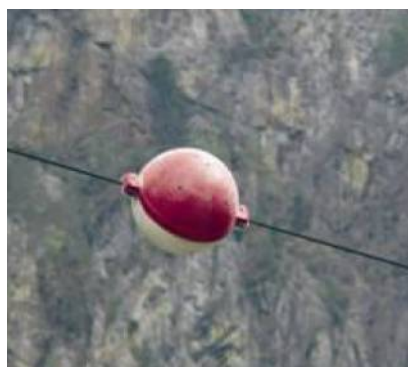
Figura 9.d: Sfere di Poliuretano utilizzate come Sistemi di Dissuasione Visiva sui Conduttori di un Elettrodotto ad Alta Tensione
