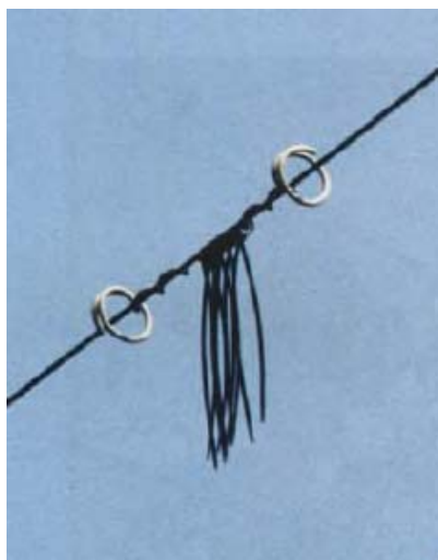
Figura 9.c: Marker utilizzati come Sistemi di Dissuasione Visiva sui Conduttori di un Elettrodotto ad Alta Tensione
