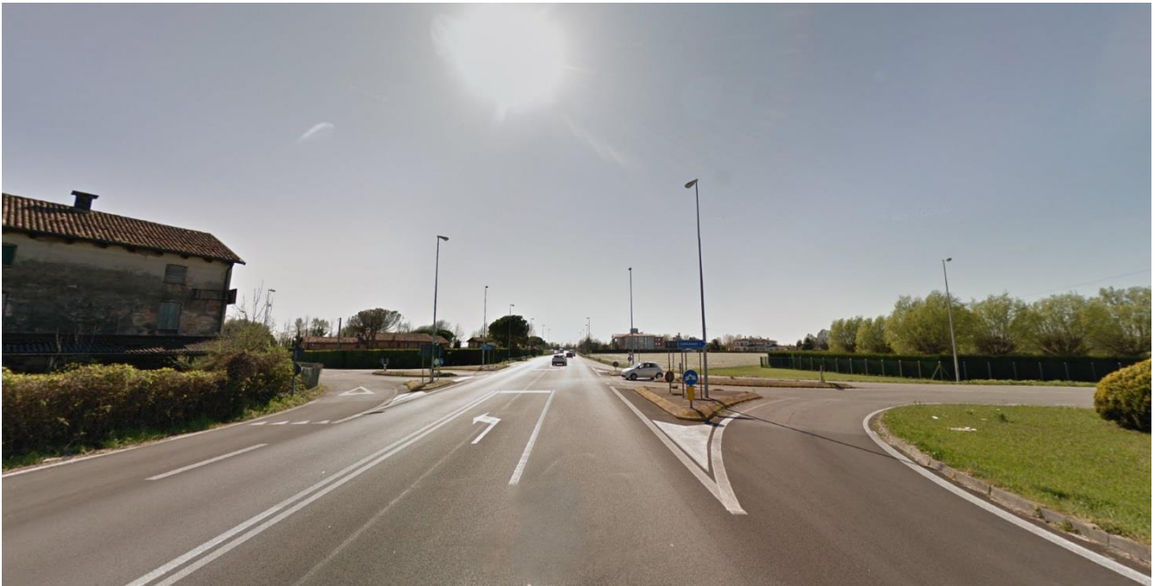
Fig 22 - Vista dell'incrocio su statale Romea da nord-est
