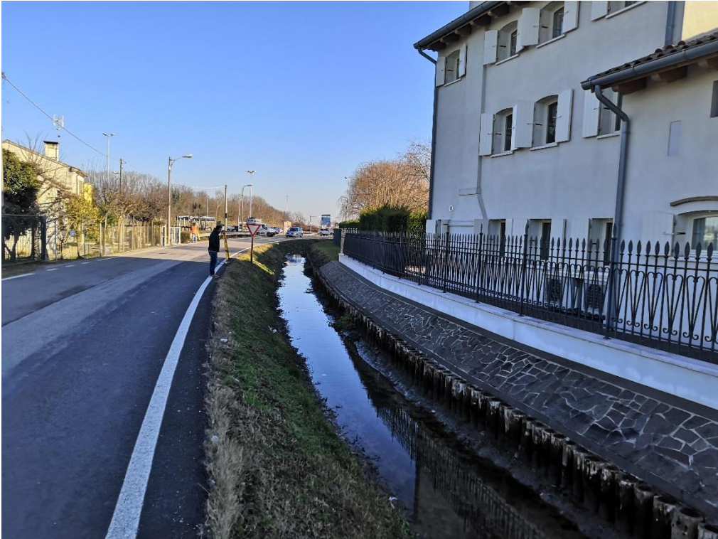
Fig 25 - Vista dell'incrocio su via Bastie da nord
