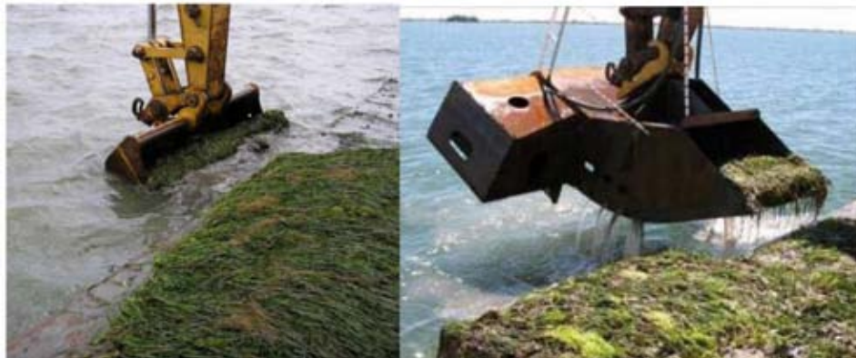
Figura 201: Fase di prelievo di grandi zolle mediante mezzi meccanici, con benna tradizionale (a sinistra) e con benna idraulica (a destra) recentemente messa a punto che permette di realizzare lo scavo per alloggiamento delle zolle contestualmente alla posa.
