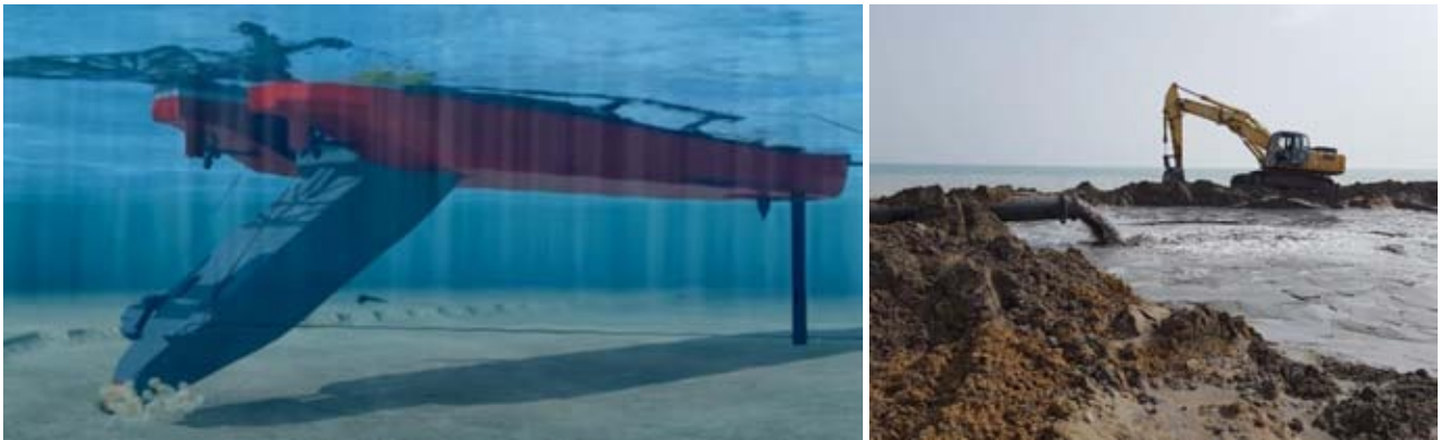
Figura 160 – Scavo con draga CSD (a sinistra, courtesy of Jan de Nul n.v.) e versamento con motopontone a fondo apribile (a destra)
