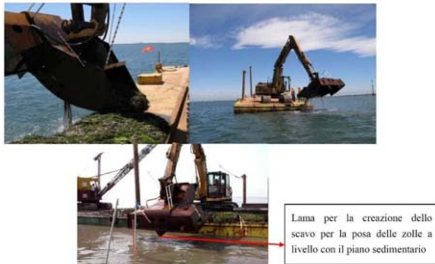
Figura 203: Benna idraulica appositamente realizzata per il prelievo di grandi zolle
