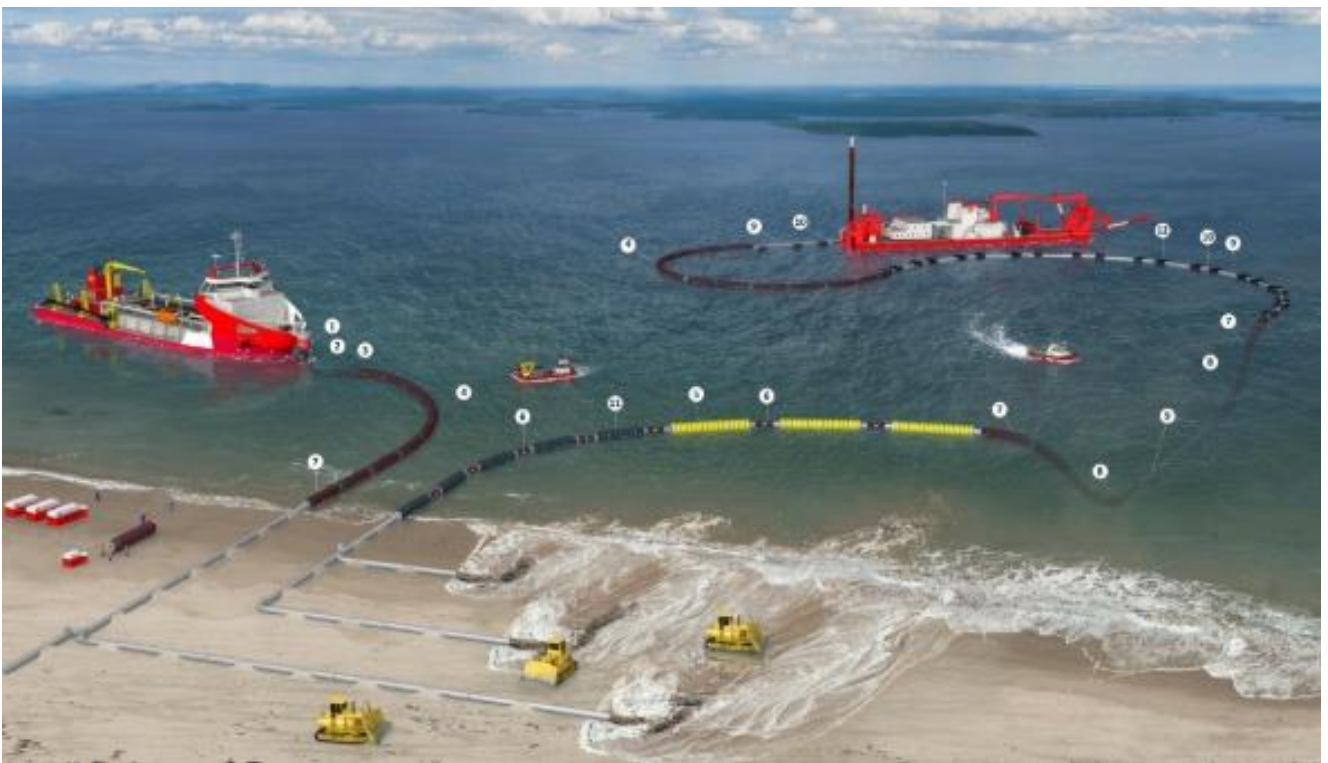
Figura 89 – Operazioni di refluento idraulico (Royal IHC, 2018)
