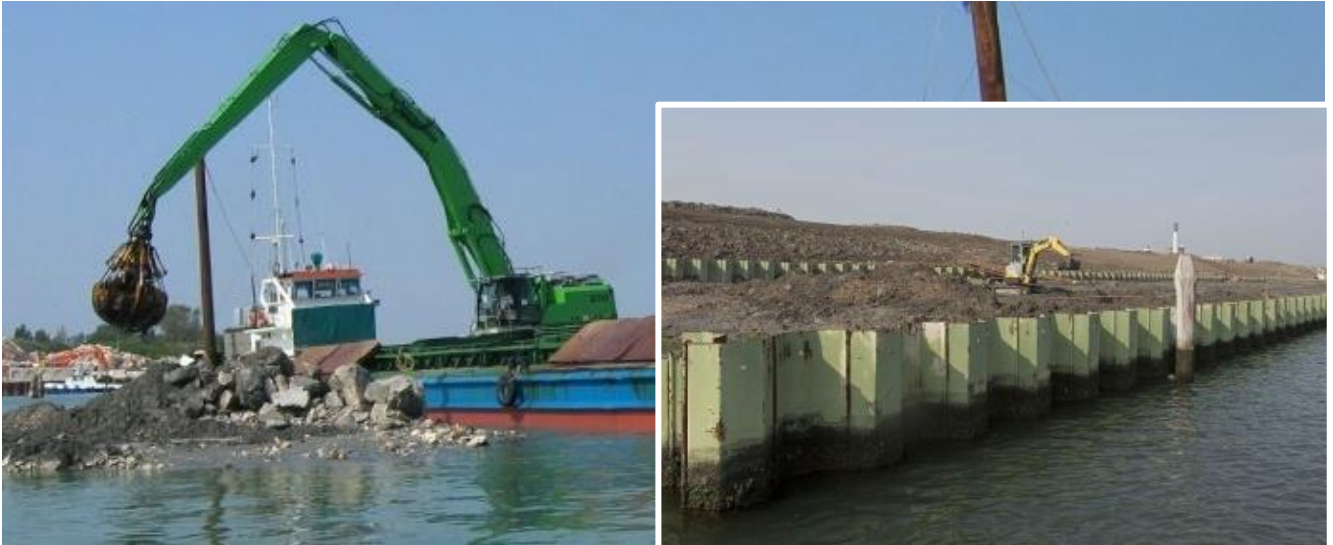
Figura 88 – Sbarco di materiale da motopontone autocaricante
