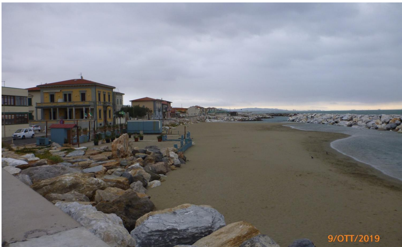
Figura 2.30 - Foto 22: Foto da imboccatura Porto di Livorno – vista verso Sud
