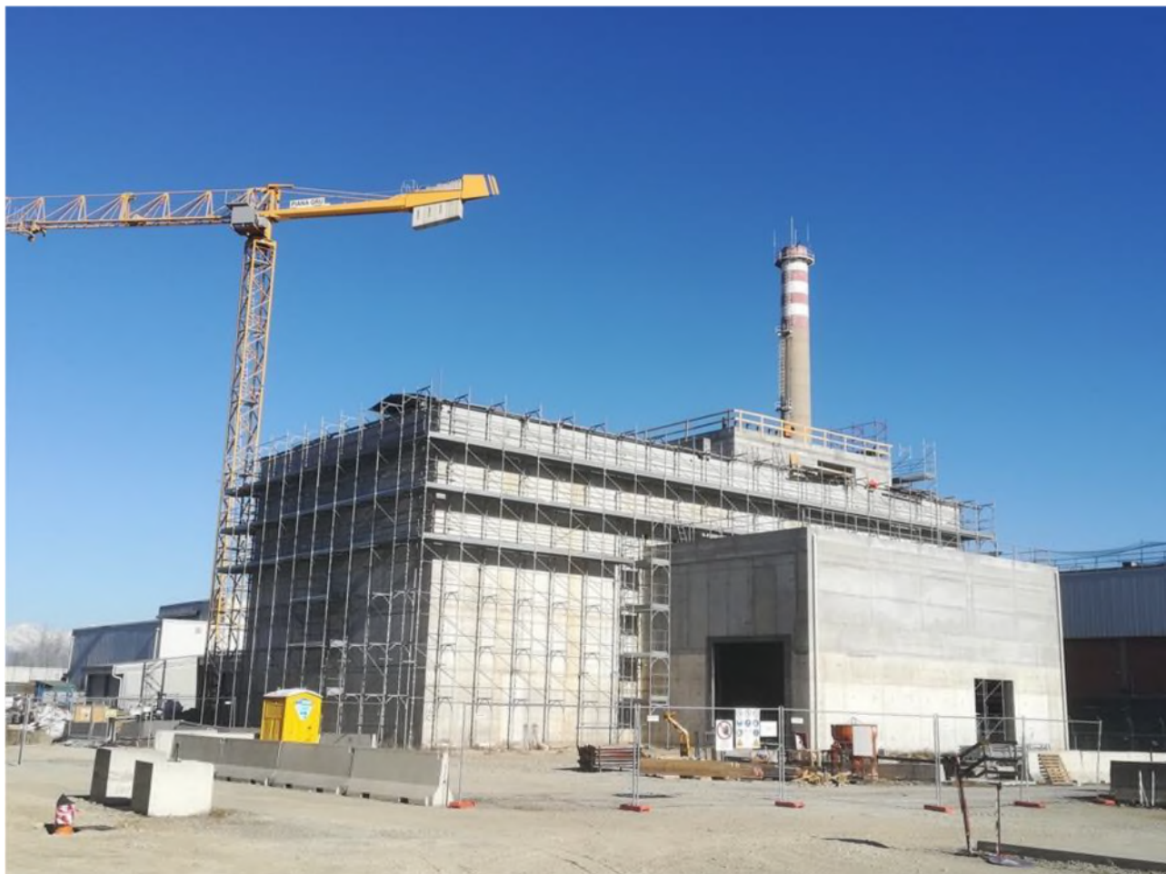
Figura 2-1 - layout di cantiere a marzo 2020 lato SSE
