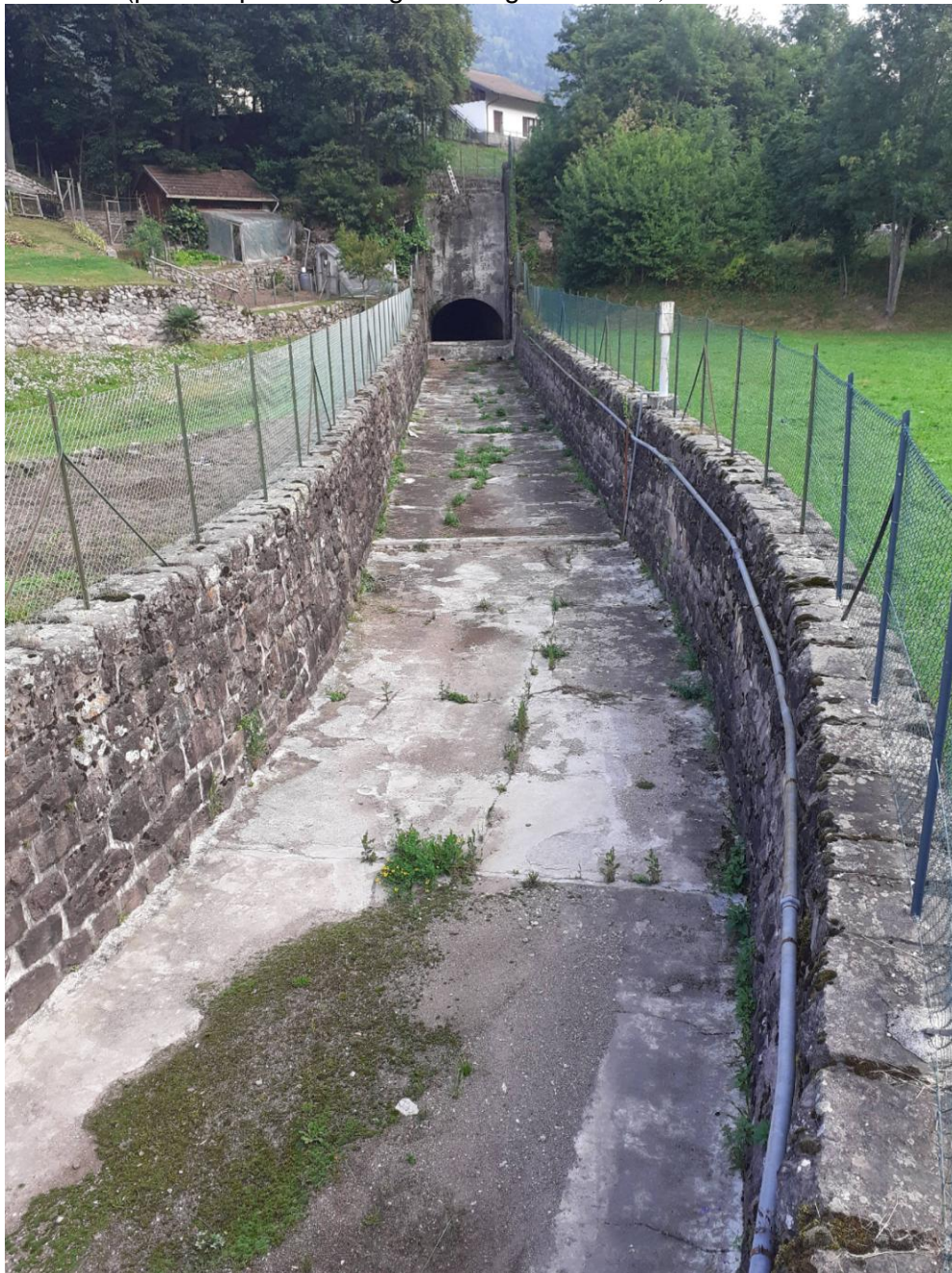
Foto n. 1 (punto A presso la Diga del Lago di Piazze)
