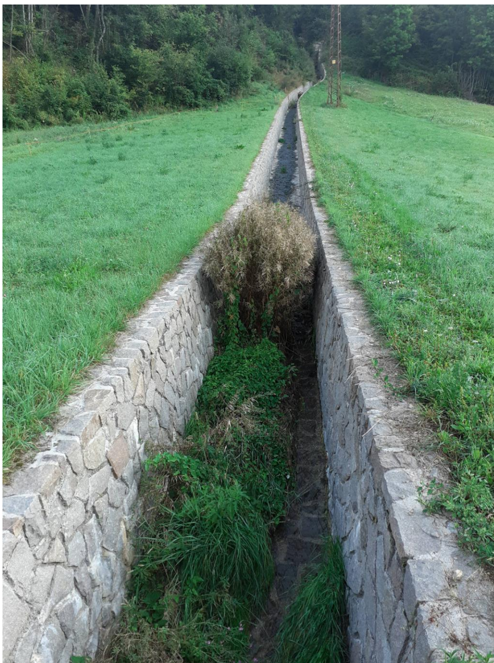
Foto n. 8 (Rio delle Lore dopo la sistemazione idraulica, si getta nel Rio Campo Roggia a monte del punto G)
