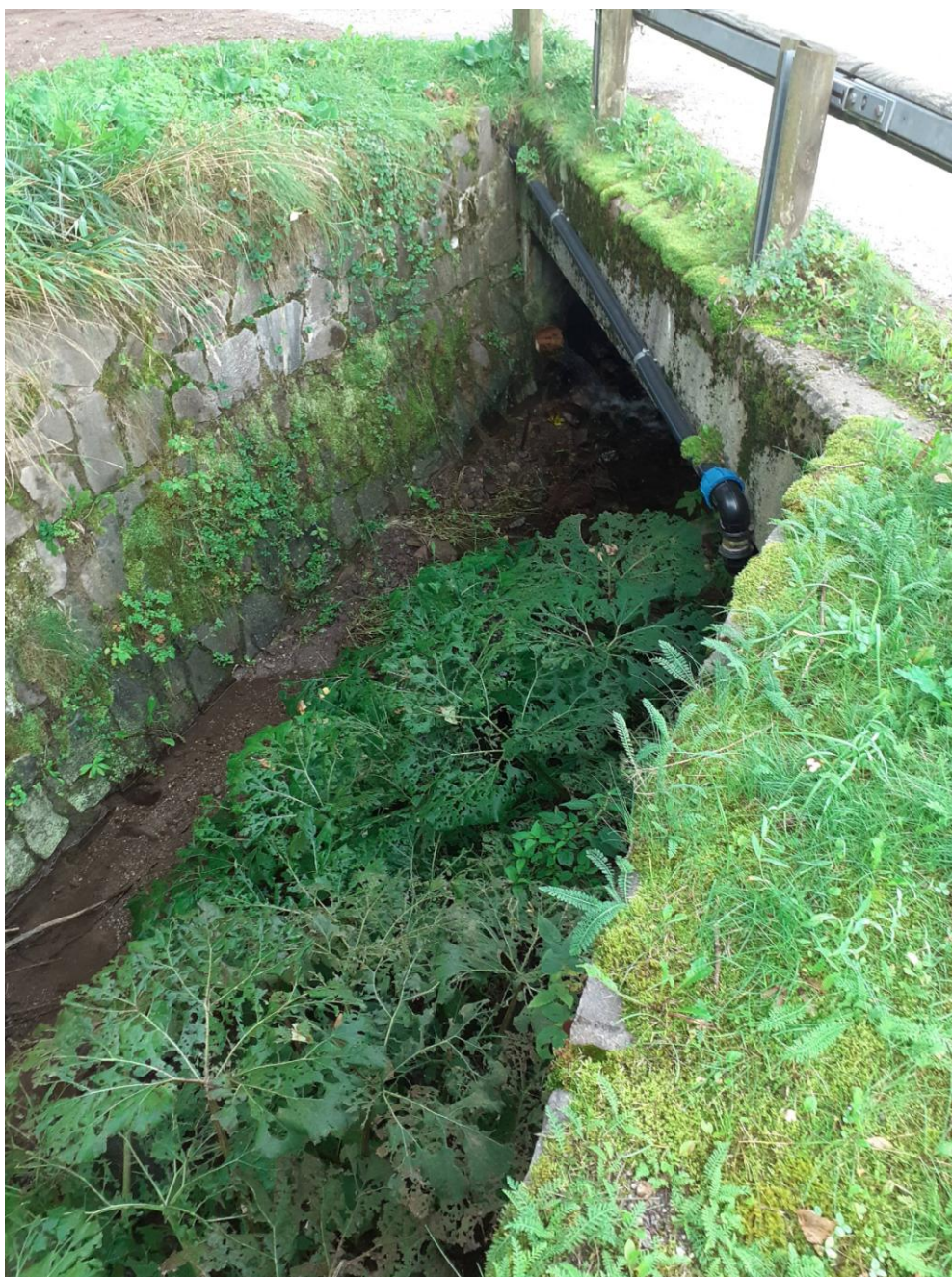
Foto n. 2 Punto C (tubo arancione sotto il ponte)
