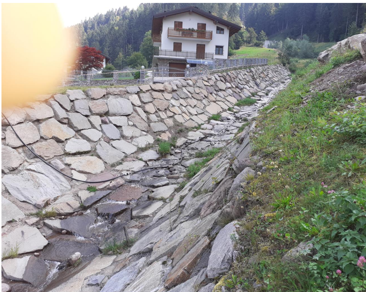
Foto n, 7 ( Rio Molinara dopo la sistemazione idraulica; si getta nel Rio Campo che convoglia le acque allo stramazzo del punto G )
