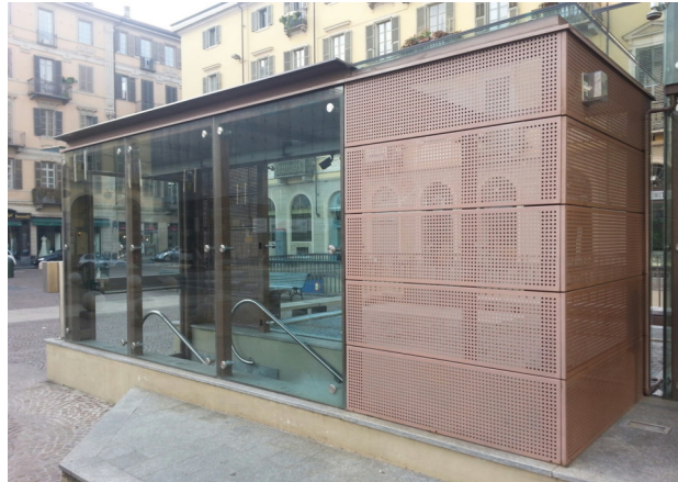
Figura 11 - Esempio copertura uscita di sicurezza città di Torino (piazza Bodoni)
