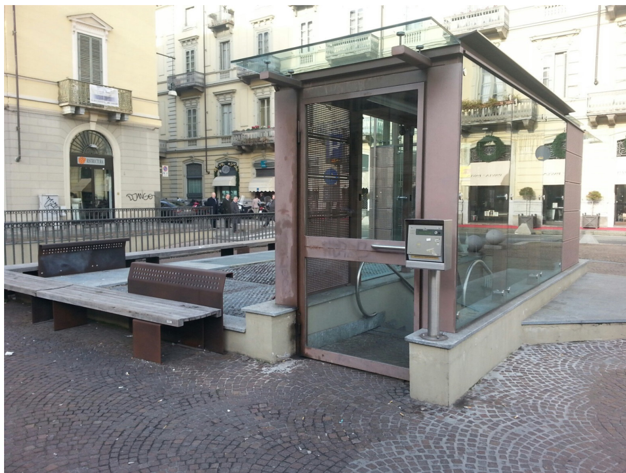
Foto 1 Esempio copertura uscita di sicurezza città di Torino (p.zza Bodoni)
