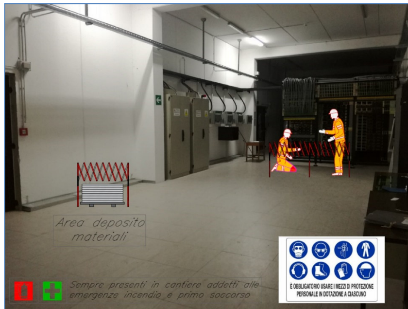
Esempio delimitazione area di lavoro in cabina
