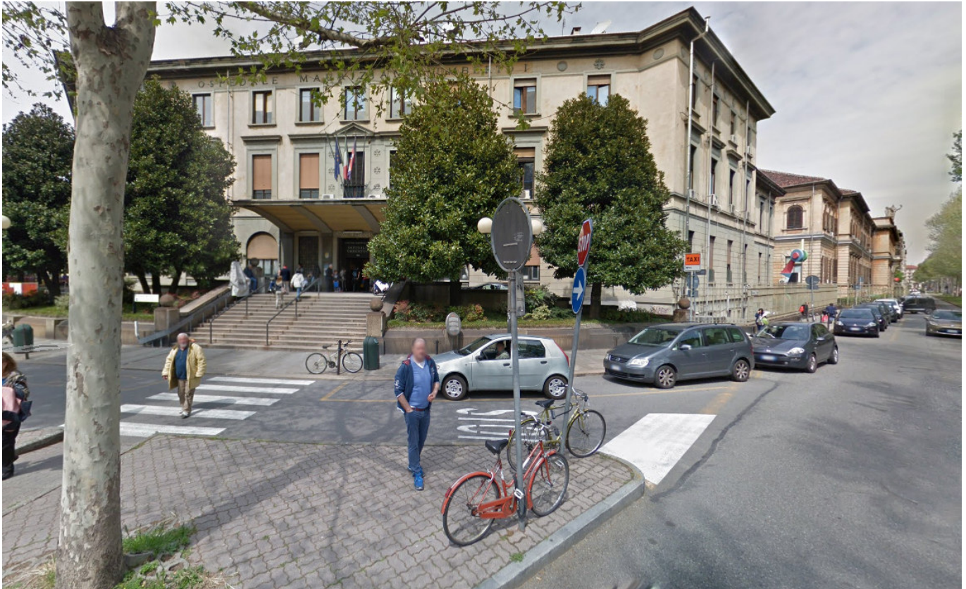
Figura 40 Complesso Ospedaliero Mauriziano: Prospetto su Largo Turati
