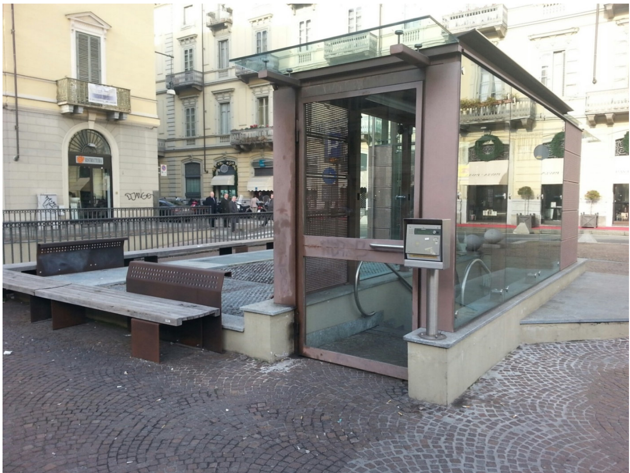
Figura 10 Esempio copertura uscite di sicurezza città di Torino (localizzata in P.zza Bodoni)
