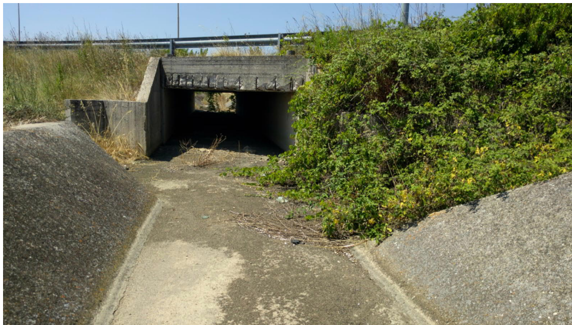
Fig. 6.1/B Tombone in corrispondenza del sottopasso della S.P.88, vista da sud
