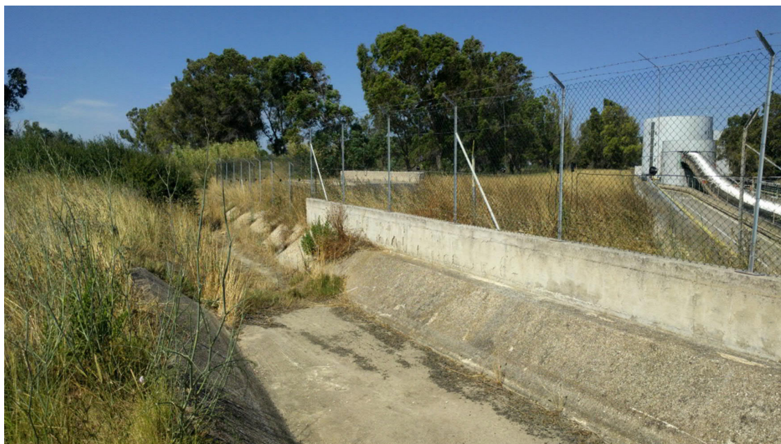
Fig.2.2/B: Foggia di Rau, zona a valle dell'attraversamento del metanodotto All. Centrale Enel Brindisi sud DN 500 (20") in corrispondenza del sovrappasso dell'asse attrezzato policombustibile – vista verso nord
