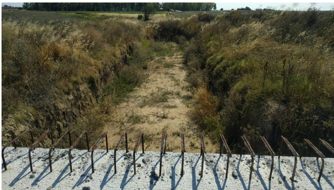
Fig.2.2/A: Affluente Fiume Grande, zona a monte dell'attraversamento del metanodotto All. Centrale Enel Brindisi sud DN 500 (20"), in corrispondenza del tombone in costruzione alla sez. 180 – vista verso nord
