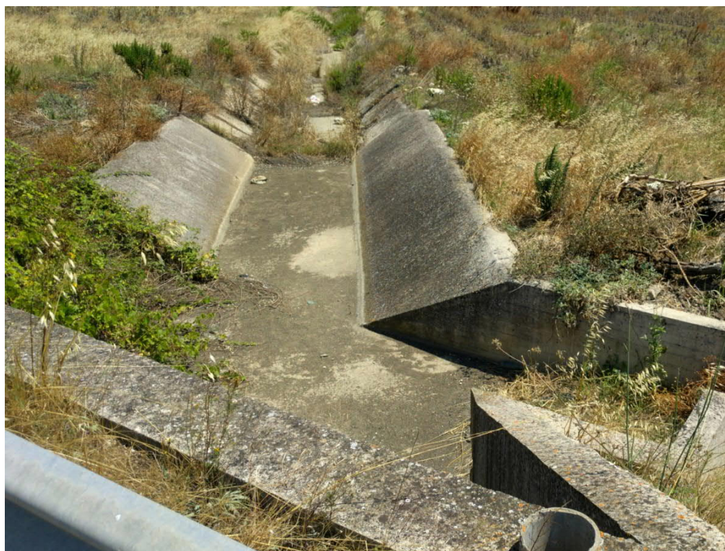
Fig.2.2/C: Canale delle Chianche, zona a valle dell'attraversamento del metanodotto All. Centrale Enel Brindisi sud DN 500 (20") in corrispondenza della sez. 30 (valle S.P.88) – vista verso nord
