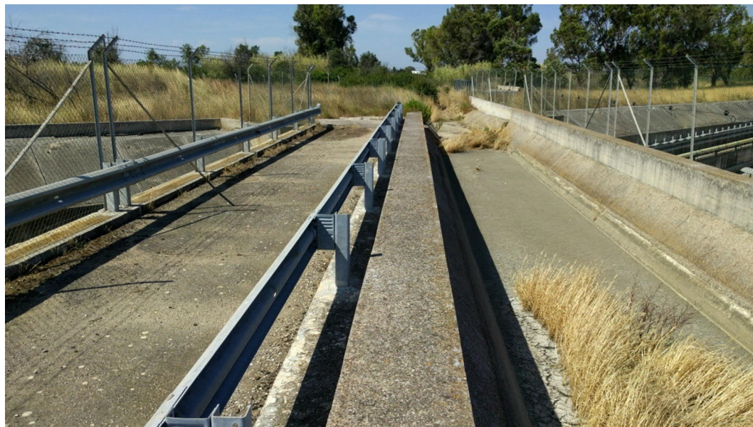
Fig.2.2/B: Canale delle Chianche, zona a monte dell'attraversamento del metanodotto All. Centrale Enel Brindisi sud DN 500 (20"), in corrispondenza del sovrappasso dell'asse attrezzato sez. 70 – vista verso sud
