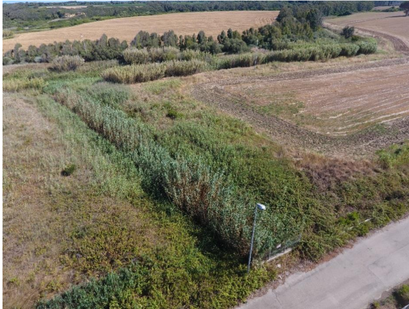
Fotografia 3: Canale della Giumenta, vista verso valle dall'attraversamento P3 all'immissione nel Siedi
