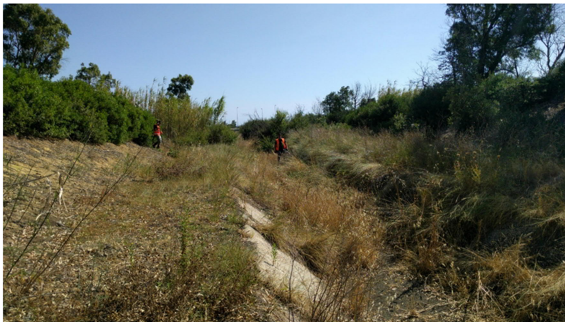
Fig.2.2/A: Canale delle Chianche, zona a monte dell'attraversamento del metanodotto All. Centrale Enel Brindisi sud DN 500 (20"), in corrispondenza del sovrappasso della sez. 80 – vista verso nord
