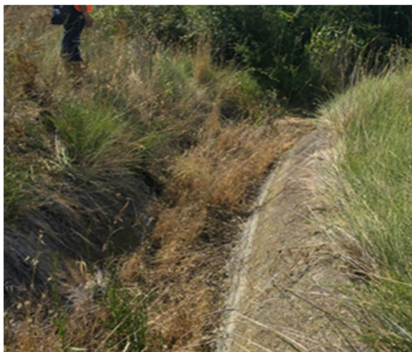
Fig.2.2/C: Affluente del Foggia di Rau, zona a monte dell'attraversamento del metanodotto All. Centrale Enel Brindisi sud DN 500 (20") – vista verso nord
