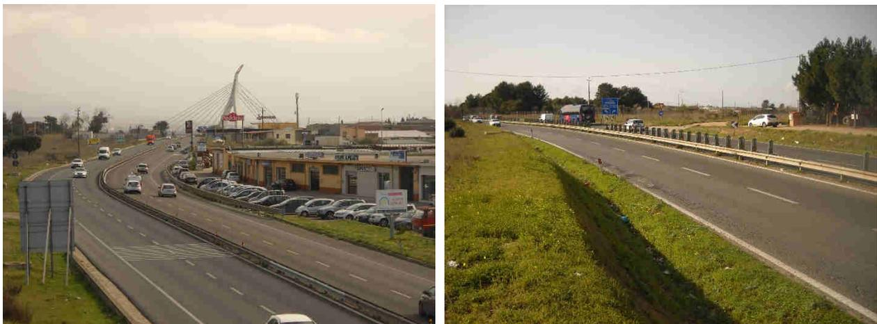
*Figura 1 – Vista dell'infrastruttura attuale. Sezione con banchina laterale (a sinistra, km.4 circa) e senza banchina laterale (a destra, km.7 circa)*
