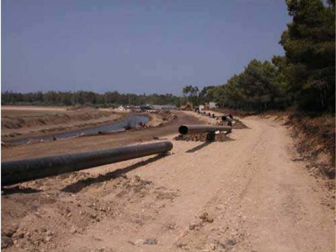
Figura 6.f: Cantiere Metanodotto, Esempio di Sfilamento Tubi
