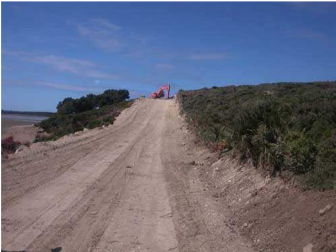
Figura 6.e: Cantiere Metanodotto, Esempio di Apertura della Pista
