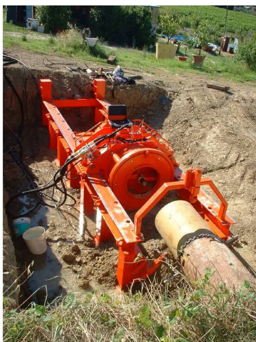
Figura 6.h: Cantiere Metanodotto, Esempio di Trivella Spingitubo
