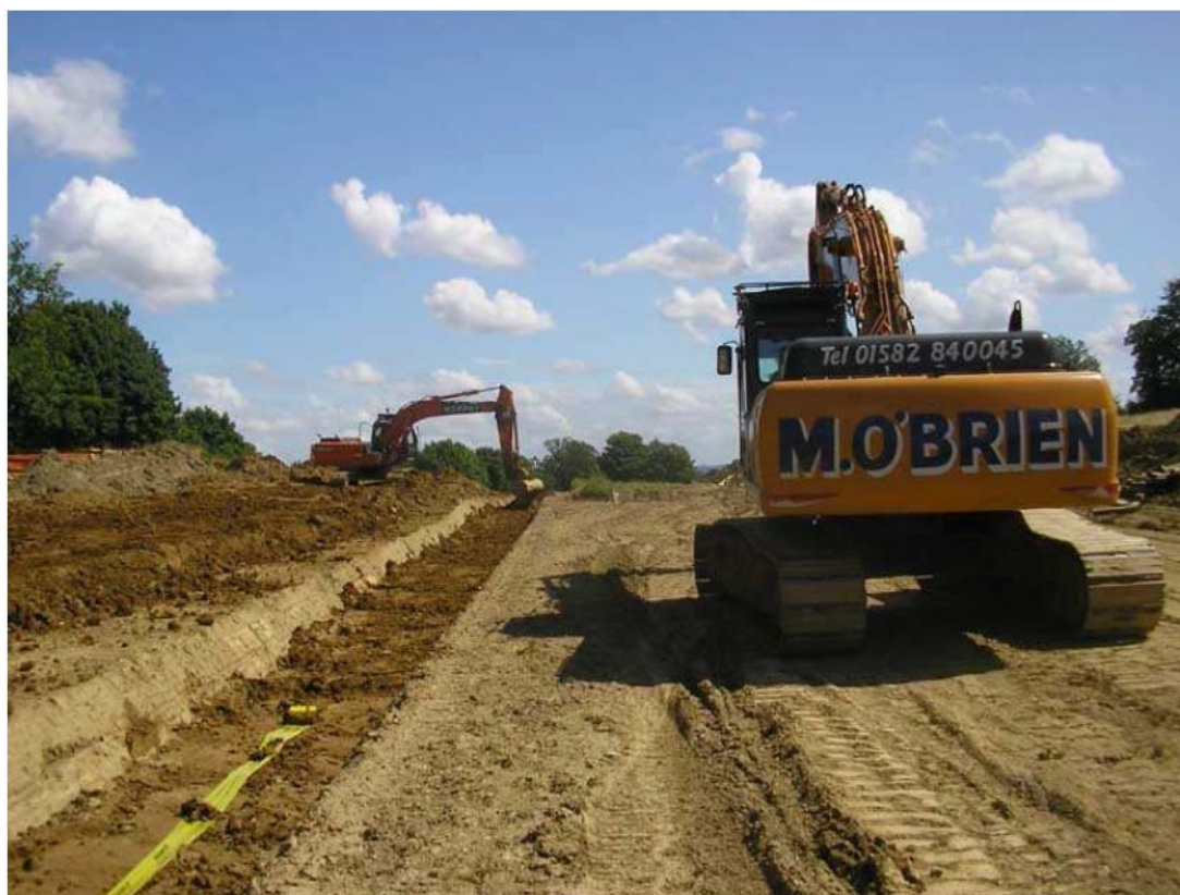
Figura 6.g: Cantiere Metanodotto, Esempio di Copertura della Trincea
