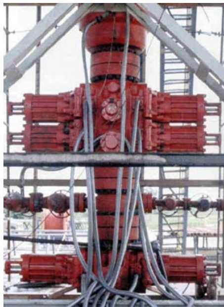
Figura 6.d: Attività di Perforazione, Blow-Out Preventer (BOP)
