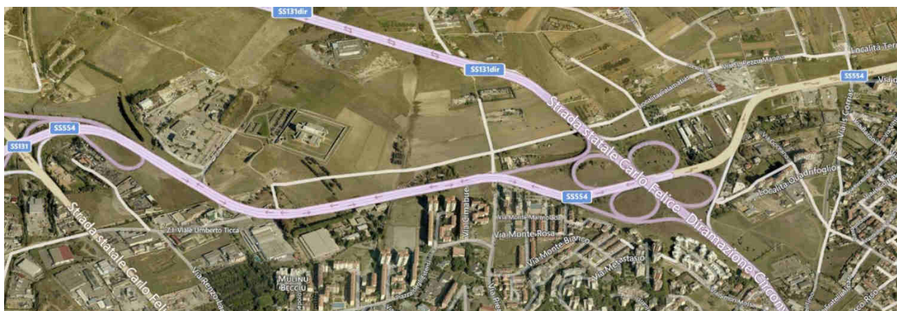
Figura 3 – Vista del primo tratto dell'infrastruttura (progr.1+500 – 4+000) con svincolo SS.131dir "Quadrifoglio"
