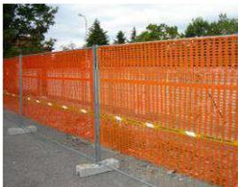
Le aree interessate dai lavori dei vari cantieri devono essere delimitate con una recinzione, realizzata con un efficace sistema di confinamento, adeguatamente sostenute da paletti fissati nel terreno, o su plinti al piede o montati su new jersey, secondo quanto previsto nel progetto esecutivo.
