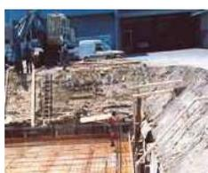
Per scavi di fondazione in genere si intendono quelli incassati ed a sezione ristretta necessari per dar luogo ai muri, ed ai plinti di fondazione propriamente detti. In ogni caso saranno considerati come scavi di fondazione quelli per dar luogo alle fognie, condutture, fossi e cunette. Qualunque sia la natura e la qualità del terreno, gli scavi di fondazione, dovranno essere spinti fino alla profondità che dalla Direzione Lavori verrà ordinata all'atto della loro esecuzione.
