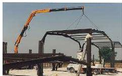
Nonostante la presenza di apparecchi di sollevamento di tipo fisso alcune attività di movimentazione dei carichi in cantiere avverrà mediante autogru con portata e caratteristiche idonee agli elementi da movimentare (materiale di scavo, elementi da rimuovere prima della realizzazione delle trincee ecc). Oltre alle istruzioni riportate nella presente scheda, i lavoratori addetti dovranno attenersi alle istruzioni
