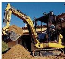
Rinterro di scavi con materiale proveniente dallo scavo e depositato in cantiere, compresi il carico, il trasporto, lo scarico e lo stendimento, nonché l'onere per il costipamento del materiale di rinterro o riporto, eseguito con mezzi meccanici.
