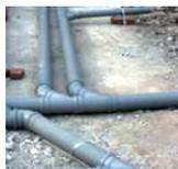
Trattasi della posa in opera di tubazioni (in ferro o p.v.c. o polietilene o rame) con giunti saldati o raccordati meccanicamente e dei relativi accessori, delle rubinetterie, ecc. in maniera da collegare i box prefabbricati ed i servizi igienici
