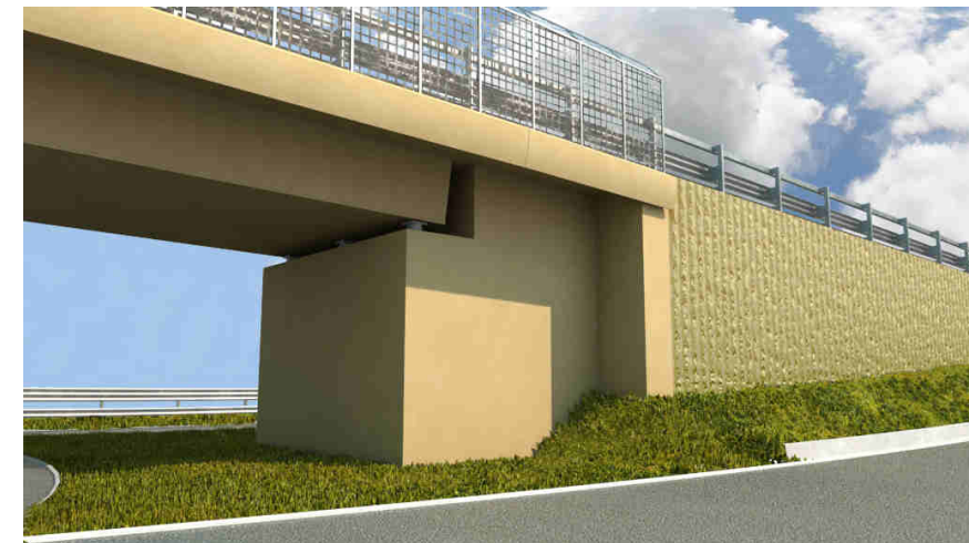
Figura 38 – Il sistema impalcato – spalla - muro
