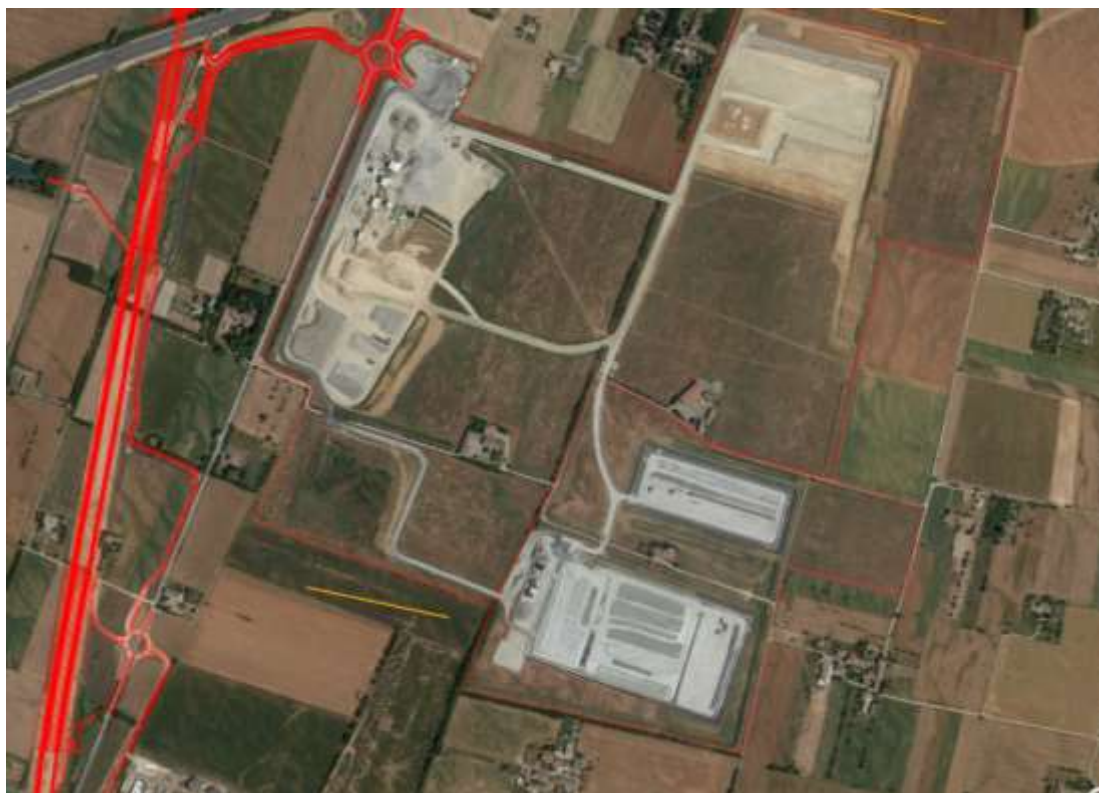
Figura 38- – Inquadrimento Aerofotogrammetrico area di cantiere
