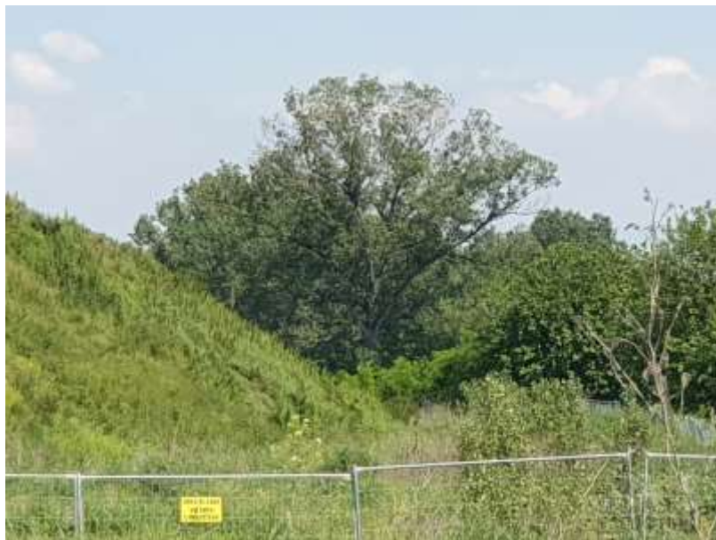
Figura 120: panoramica stazione di rilievo VEG-AL-002, vista da ovest (maggio 2019)
