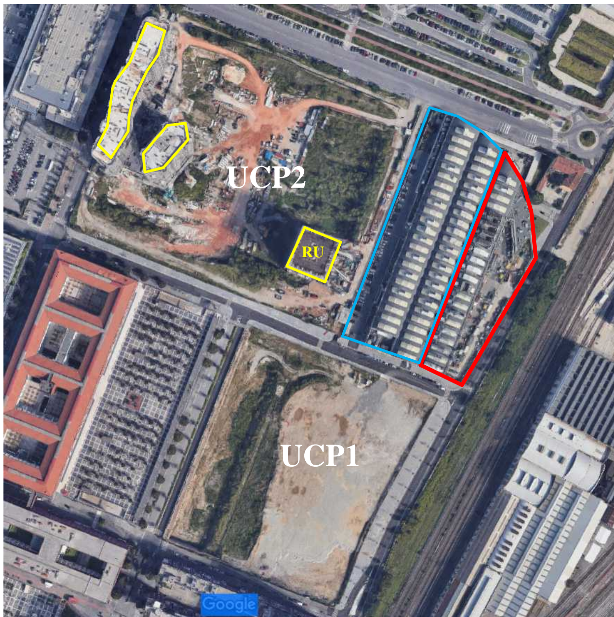
Figura 1. Contesto urbanistico del circondario della centrale Tecnocity, fotografia satellitare Google Maps (vista in modalità Globo). In rosso è contrassegnato il perimetro dell'area di proprietà della centrale, in azzurro quella dell'impianto Pirelli. In giallo alcuni dei fabbricati tuttora in fase di costruzione dell'area UCP2
