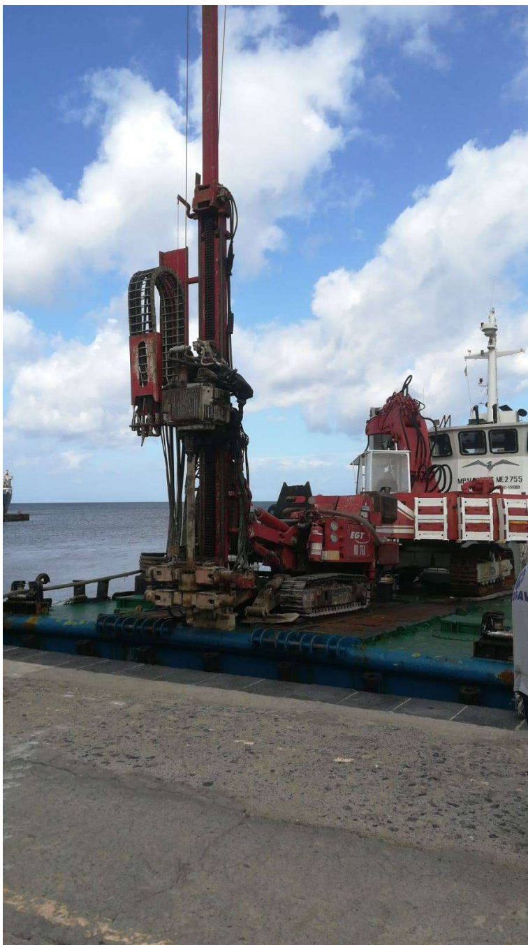
Figura 5 – Moto Pontone albatros ormeggiato con la sonda perforatrice EGT MD 710 già installata a bordo.
