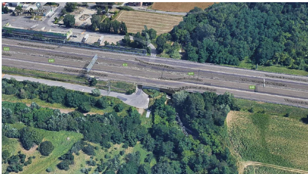
Figura 2 - Viadotto Savena A14 al km 21+312
