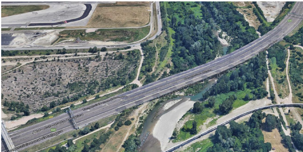
Figura 1 - Viadotto Reno A14 al km 9+925
