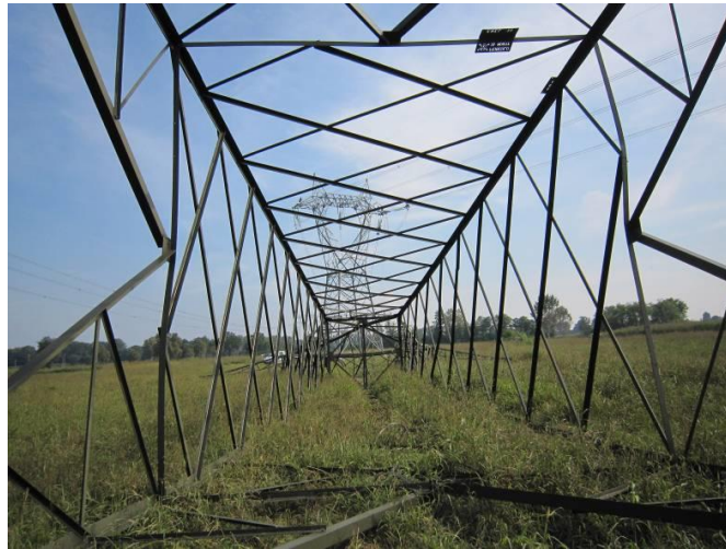
Figura 55 - Fasi demolizione di un sostegno a traliccio
