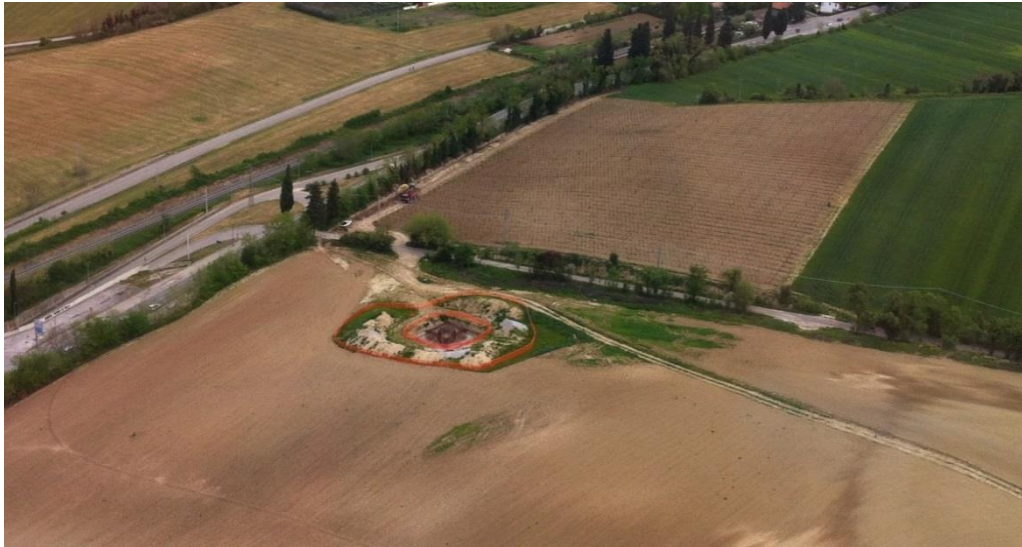
Figura 9 - Area Sostegno veduta dall'alto dell'estensione complessiva del micro-cantiere
