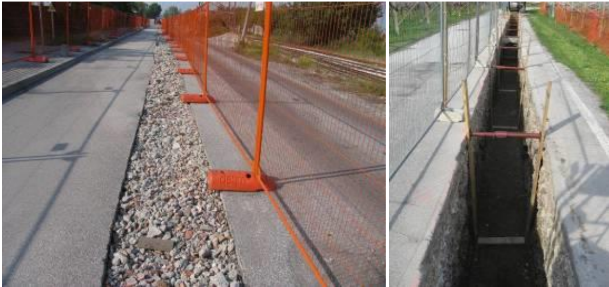
Figura 40 - Taglio dell'asfaltatura e scavo aperto
