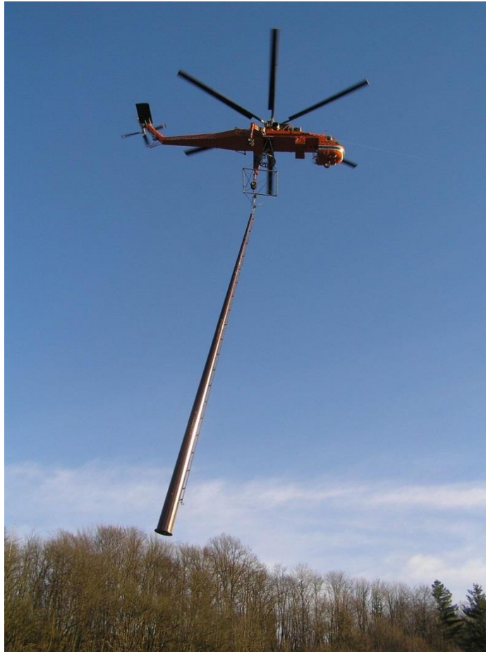
Figura 33 - Trasporto di un sostegno con elicottero Erickson
