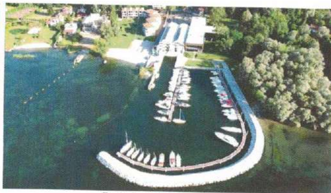
Stato "post operam"
