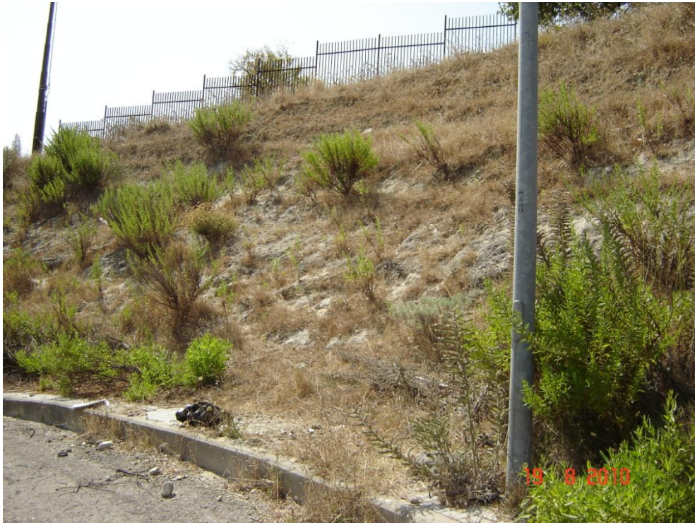
Punto 4 – fronte su cui è stato eseguito il campionamento
