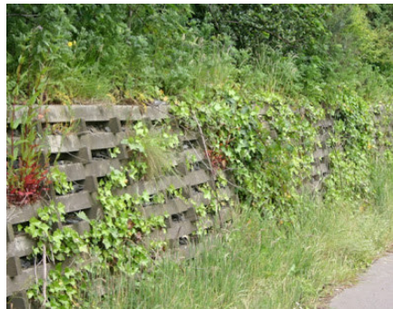
Figura 34.: Esempio muri tipo “crib wall”
