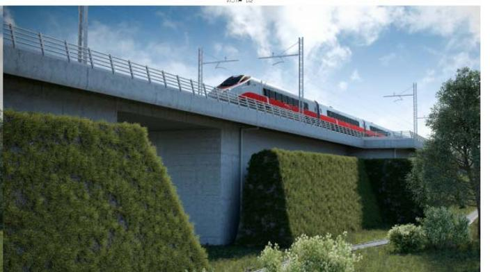
**Foto-inserimento della modellazione morfologica del rilevato in c.a. e assetto dell'area tra la stazione di Hirpinia e viadotto VI01 prevista in Progetto Esecutivo**
