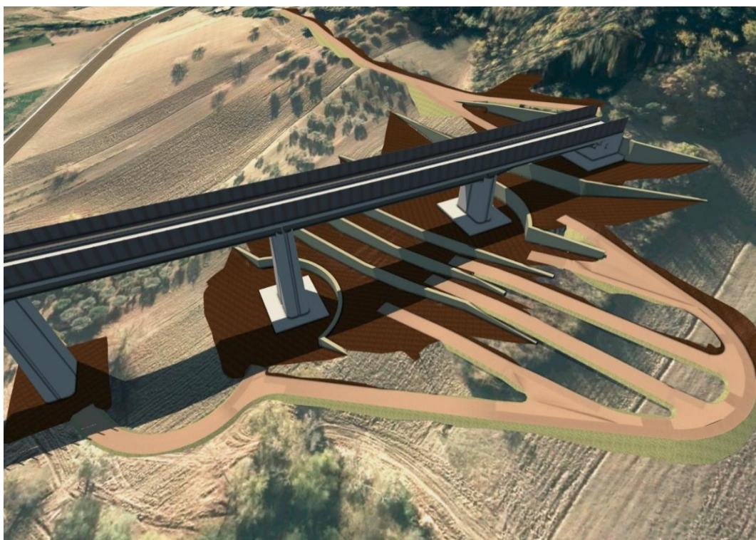
Figura 5-3. Viadotto VI03: Gradonatura e opere di stabilizzazione versante Ovest – lato Galleria Rocchetta
