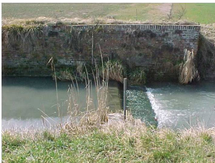
A monte dell'opera di presa
