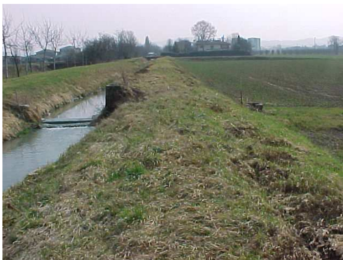
Argine in sinistra idraulica
