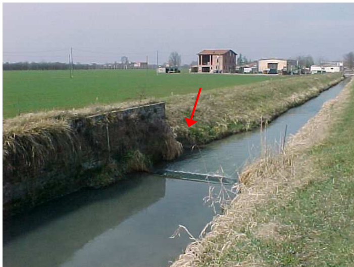
Ubicazione opera di presa dal canal Torbido (vista da monte)
