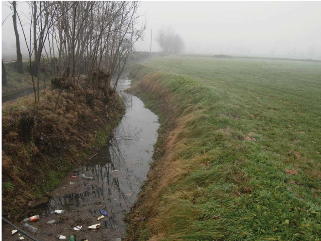
Fig. 7 – Canale che attraversa il settore centrale
