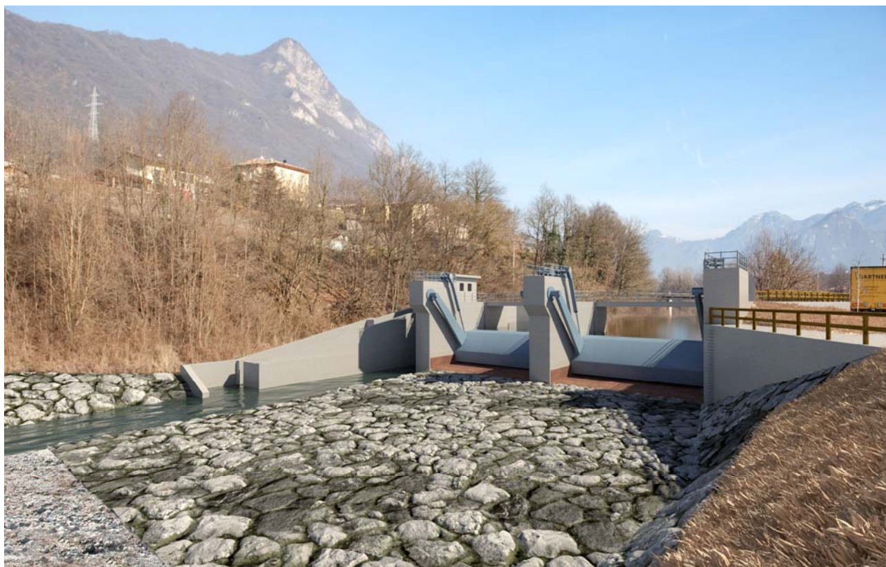
Figura 24: vista da valle della nuova traversa con passaggio del minimo deflusso vitale e raffronto con lo stato di fatto (sopra)
