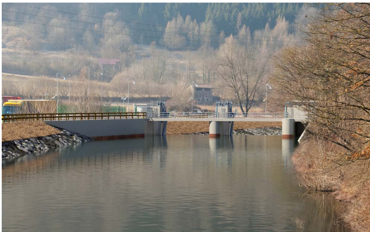
Figura 23: vista da monte della nuova traversa con livello alla massima regolazione di 368.00 m slm e raffronto con lo stato di fatto (sopra)
