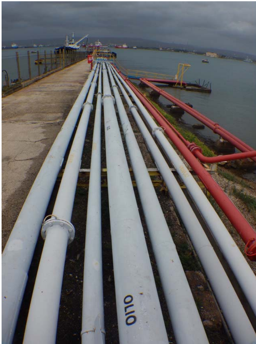
2.2. ZONA DI ATTRACCO DI TESTA PONTILE (FOTO 2)
