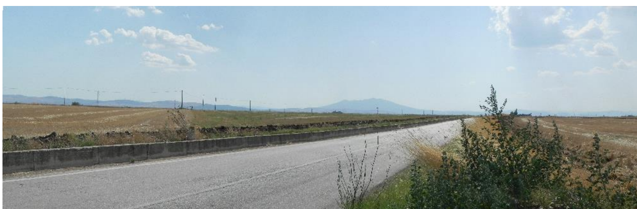
Figura 33: Stato dei luoghi in corrispondenza del punto di ripresa fotografica E
