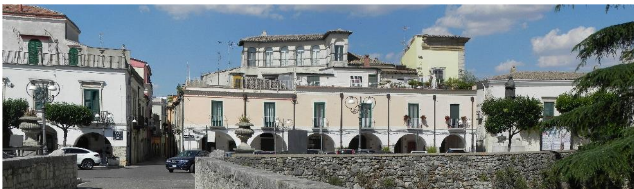
Figura 36: Stato dei luoghi in corrispondenza del punto di ripresa fotografica H
