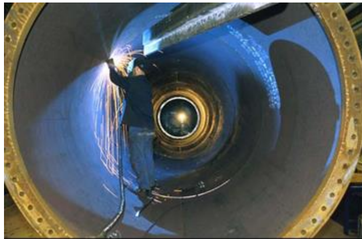
Figura 10: interno di una torre
