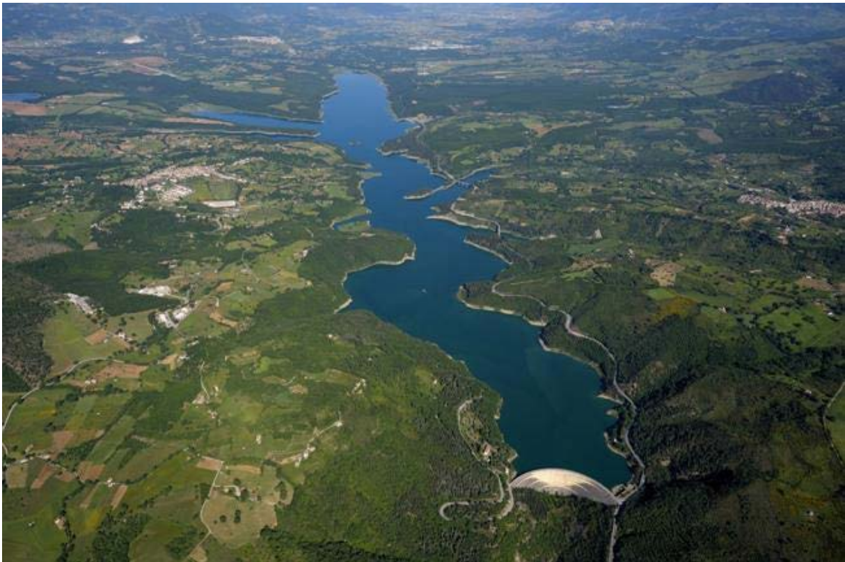
Figura 10. Vista panoramica del lago del Pertusillo
