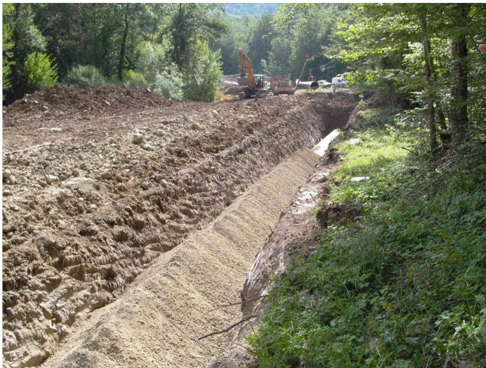
Fig. 6.9.1- Posa e reinterro della condotta
