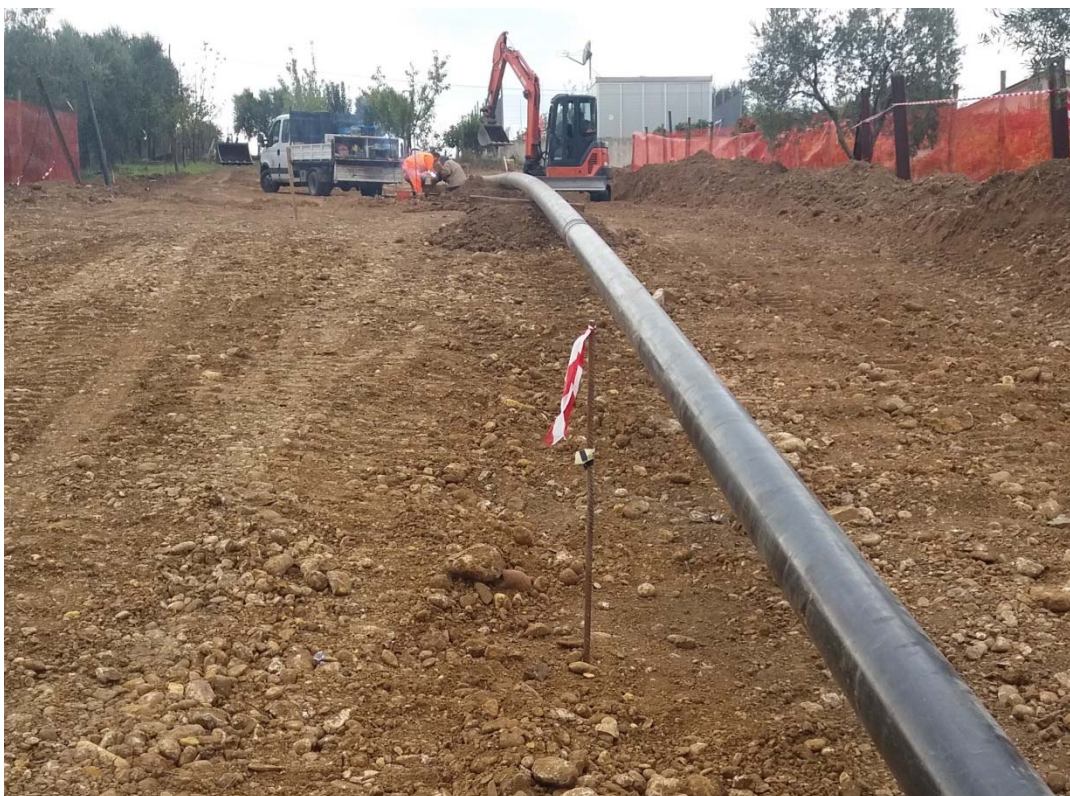
Fig. 6.4.1 - Saldatura della tubazione
