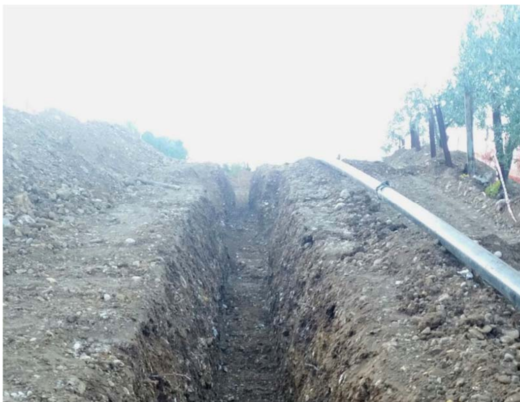
Fig. 6.5.1 - Scavo della trincea
