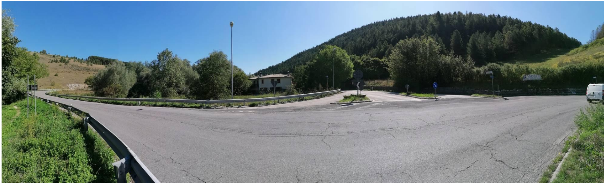
Fase C.O. Settembre 2019
