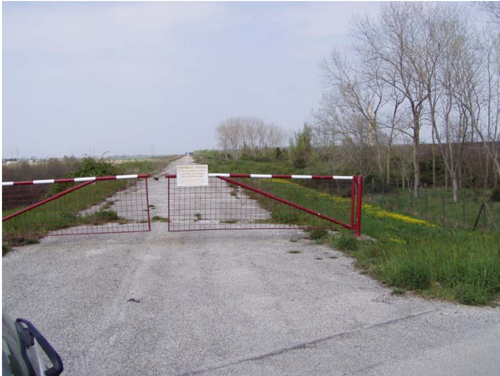
FOTO 2 – Particolare dell'argine di seconda linea
