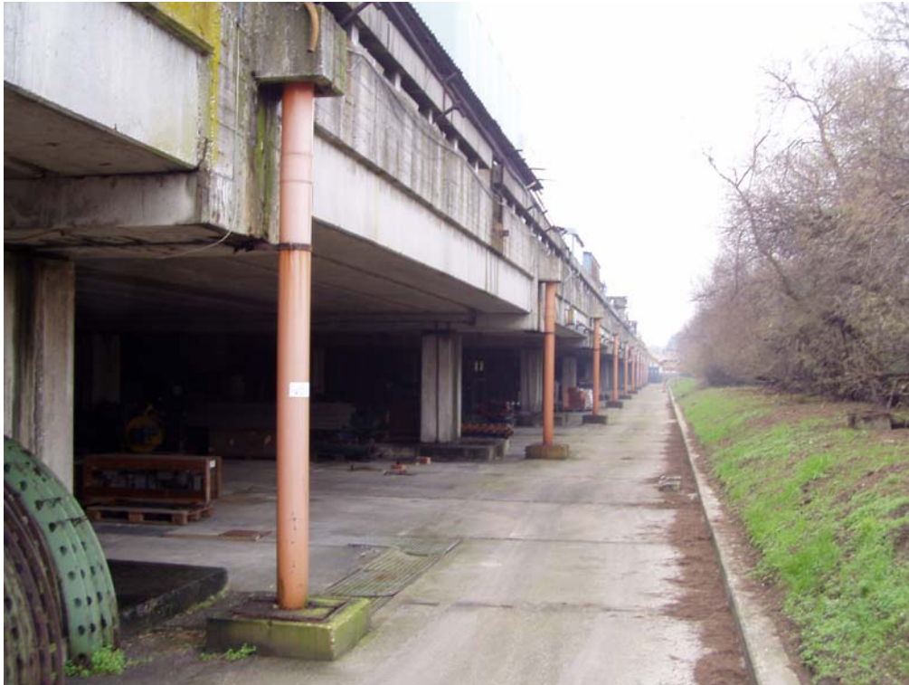
FOTO 4 – Bordo dello zatterone poggiate su pilastri e pali su cui sono ubicate le strutture di centrale
