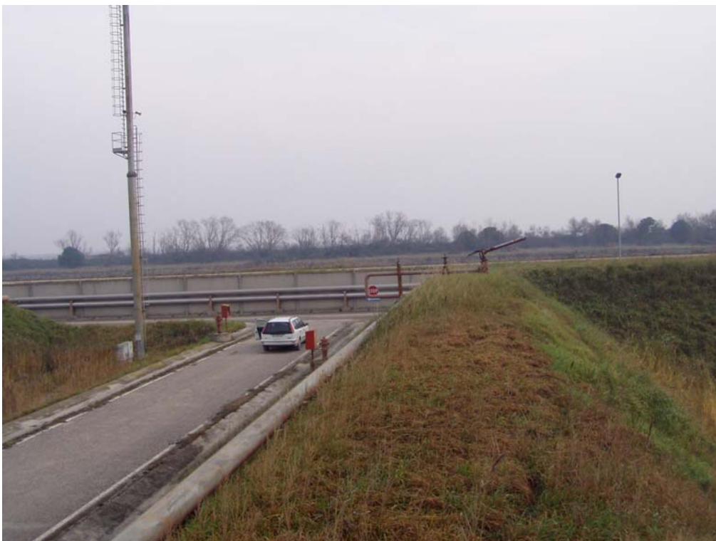
FOTO 3 – Particolare di un argine di contenimento dei serbatoi del parco sud.
