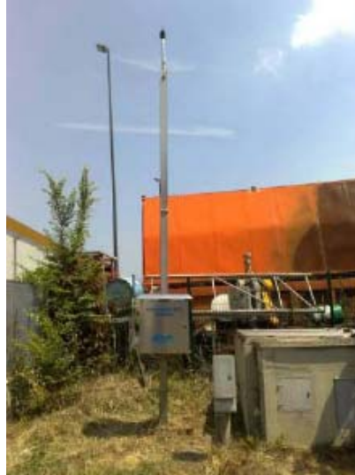
Img. 3.6 – Postazione N°1
