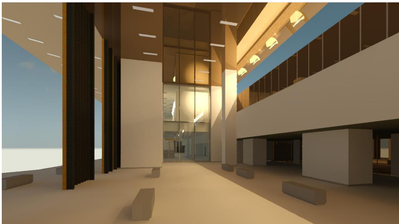
Figura 3 – Vista di insieme e di dettaglio lato ingresso
