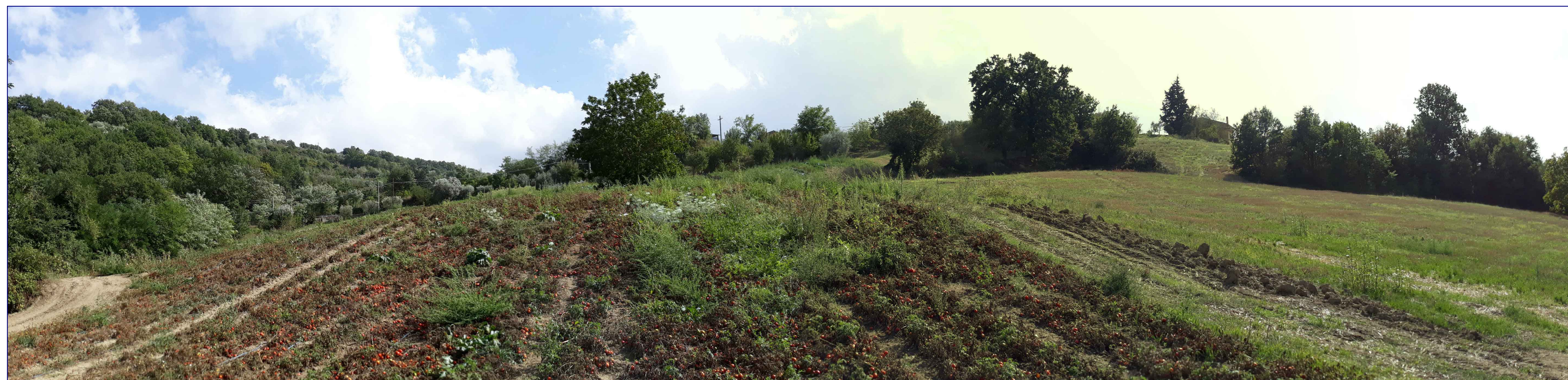
FOTO DI INQUADRAMENTO DELL'AREA DI IMBOCCO
