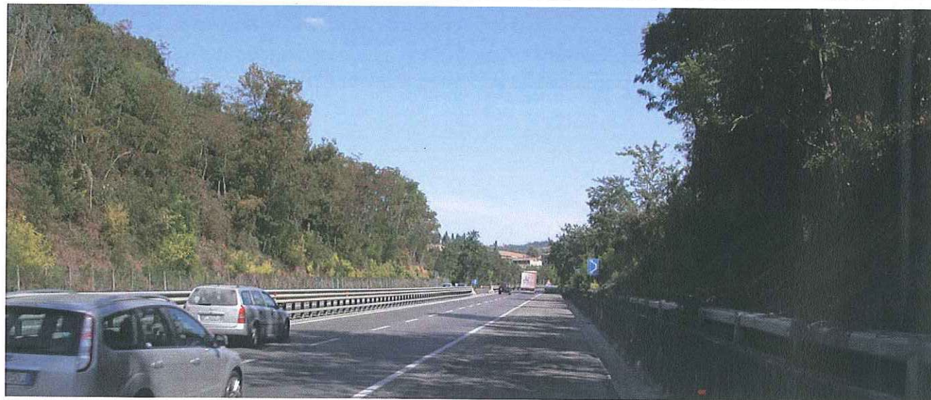
Raccordo autostradale FI-SI, Km 7+000. Fascia di vegetazione spontanea lungo il tratto di trincea, corsia nord.
