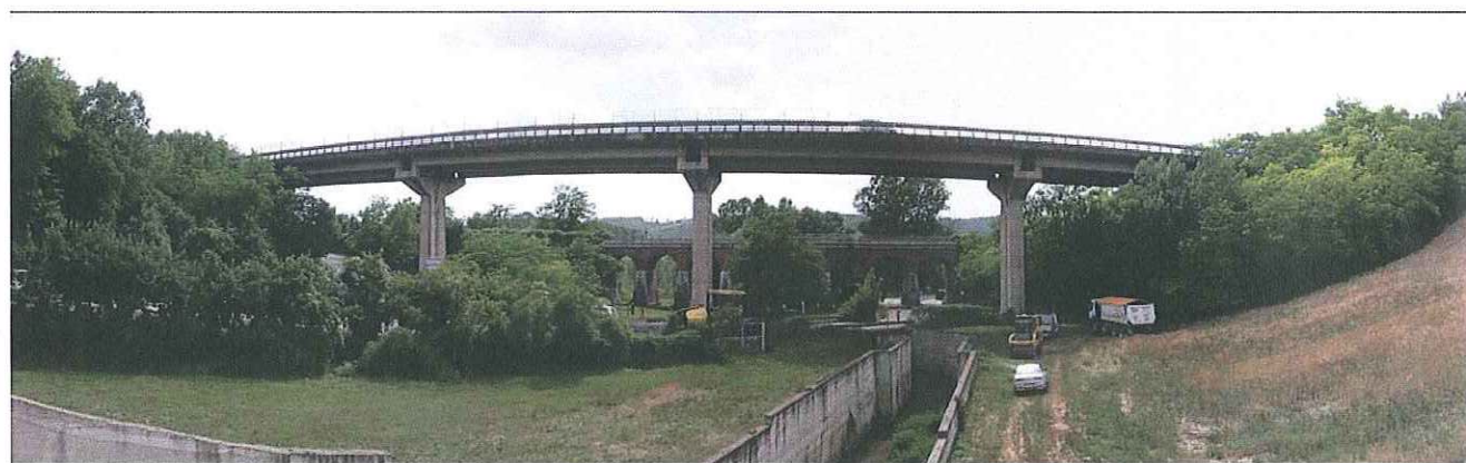
Attuale ponte Otto Archi – Attraversamento del Torrente Staggia
