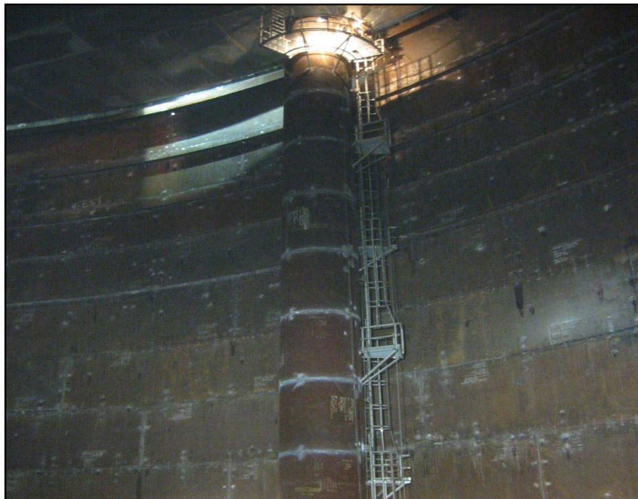
**Costruzione dello stand pipe con scale e piattaforme**
