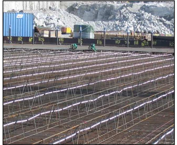
**Posizionamento delle armature e dei condotti di riscaldamento all'interno della platea**
