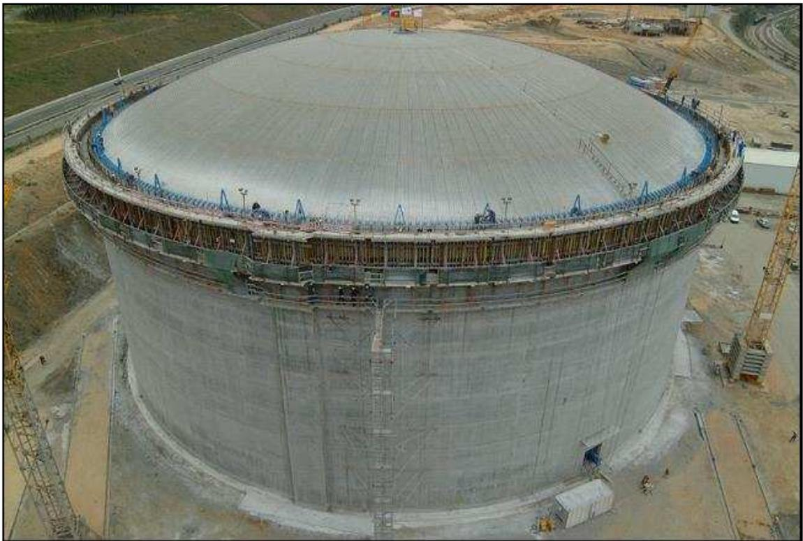
**Copertura in cima alla parete di calcestruzzo e saldatura all'anello di compressione**
