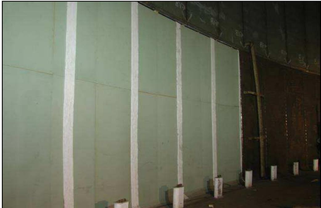
**Posizionamento dell'isolamento della protezione d'angolo**
