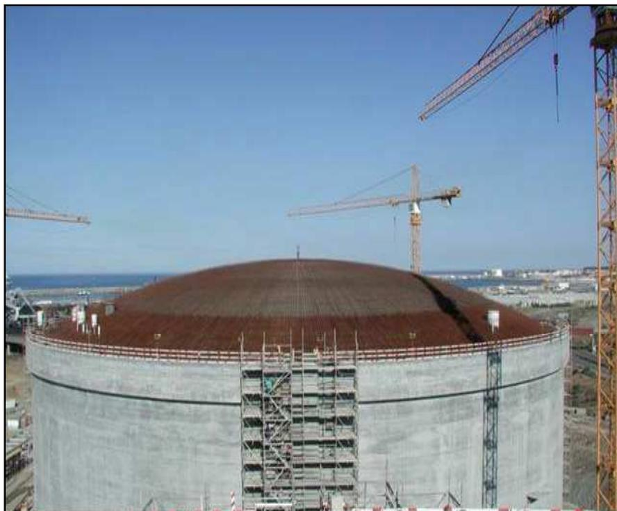
**Posizionamento delle armature sulla copertura**
