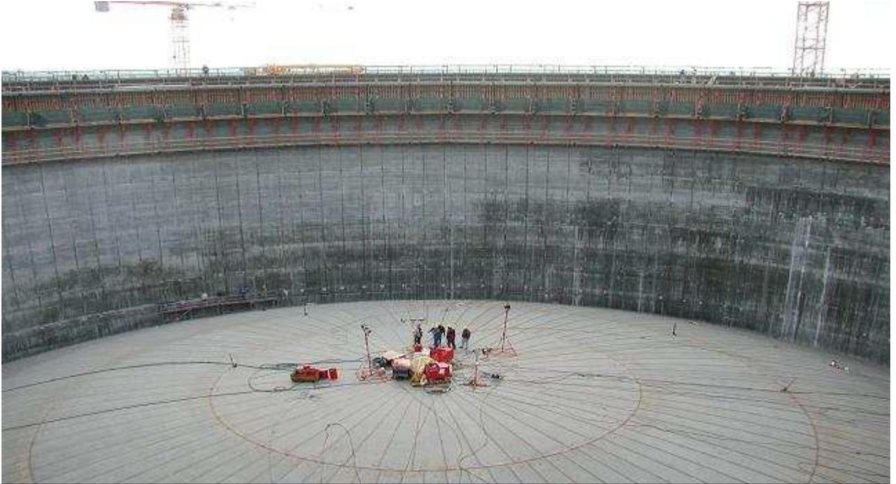
**Smontaggio del supporto centrale al completamento della copertura**
