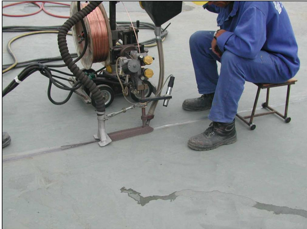
**Saldatura lamiera di fondo (acciaio al carbonio)**
