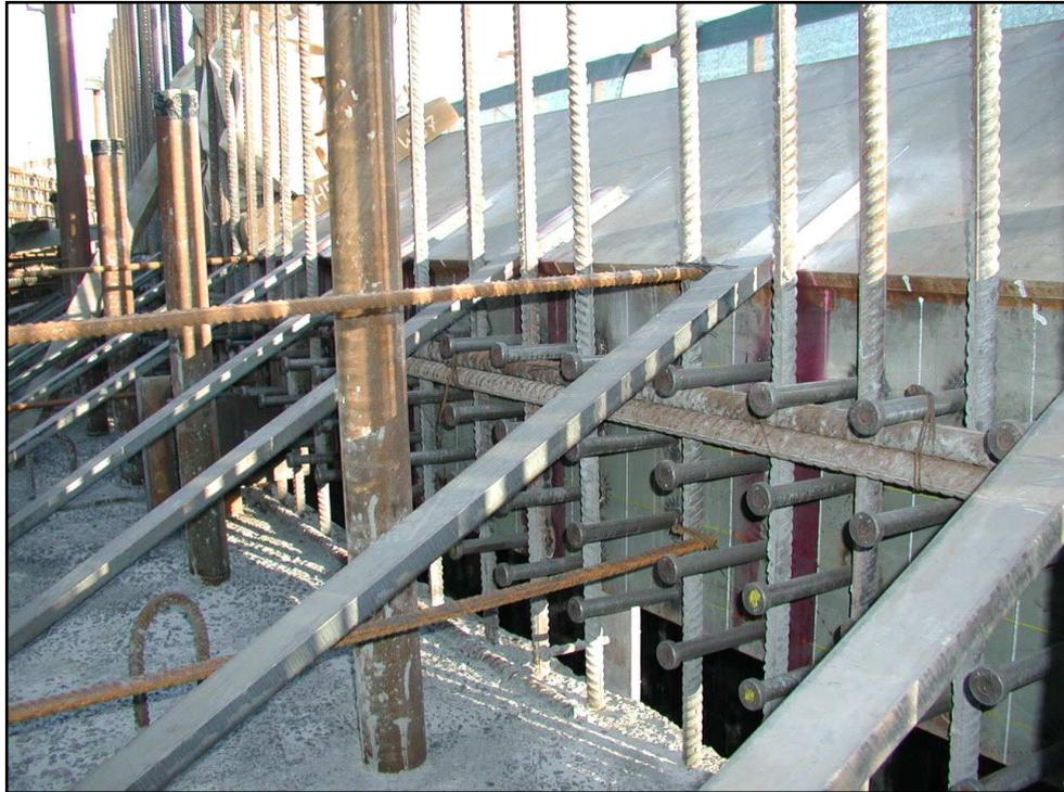
**Sollevamento e saldatura dell'anello di compressione**
