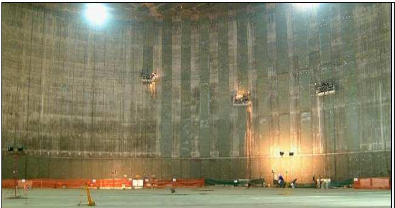
**Saldatura lamiera di parete (acciaio al carbonio)**
