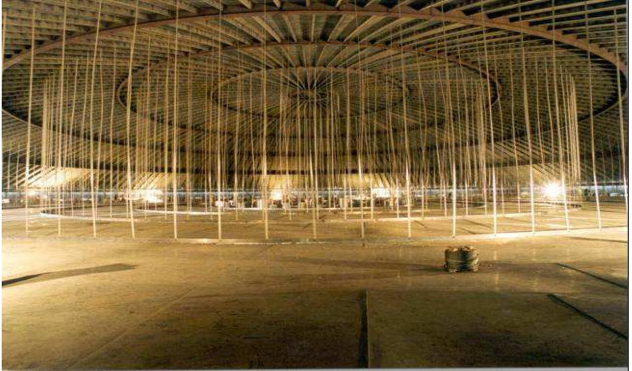
**Sollevamento e assemblaggio dell'impalcato sospeso in alluminio**
