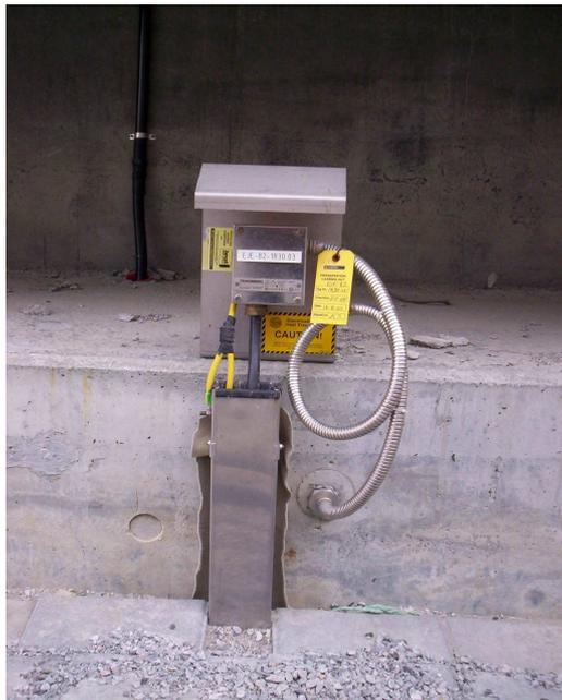
**Scatola di giunzione del sistema di riscaldamento**
