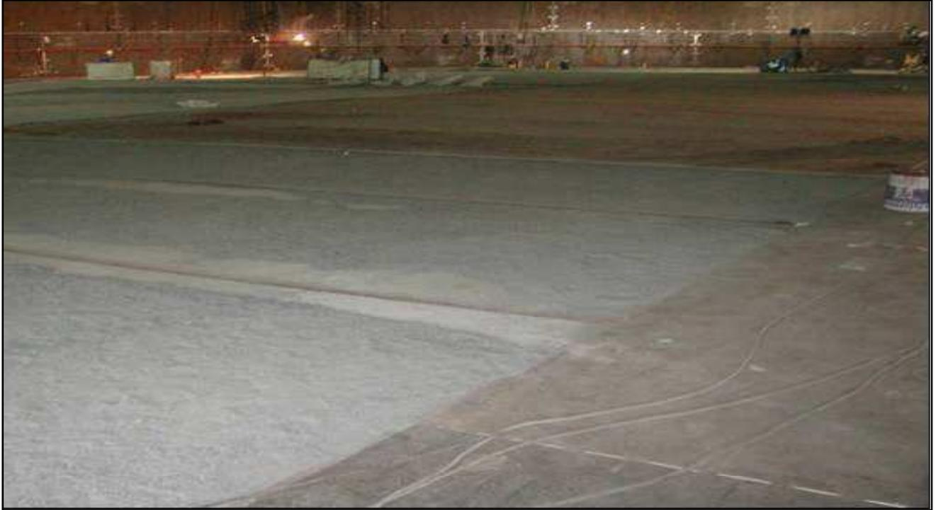
**Assemblaggio lamiere di fondo serbatoio interno (9% Ni)**
