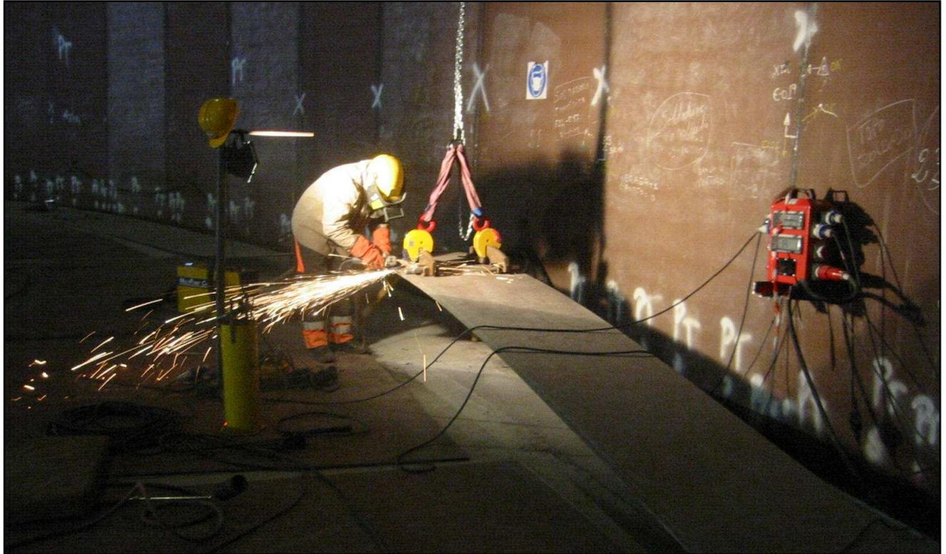
**Costruzione piastre anulari del serbatoio interno**
