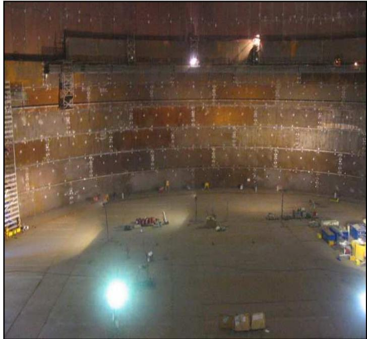
**Sollevamento e saldatura del serbatoio interno al 9%**
