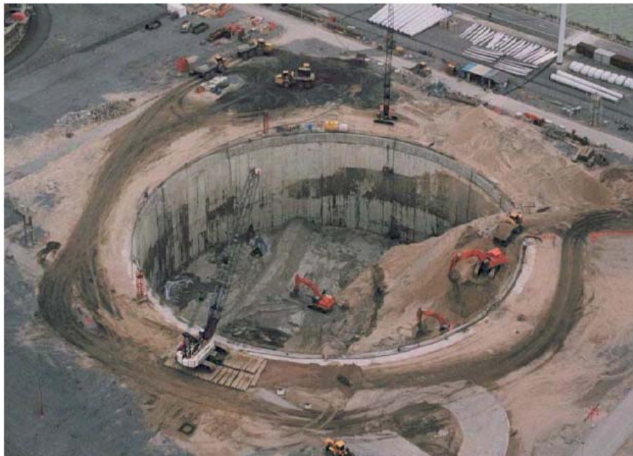
Figura 3.5: Scavo da +1 m slm a - 14 m slm
