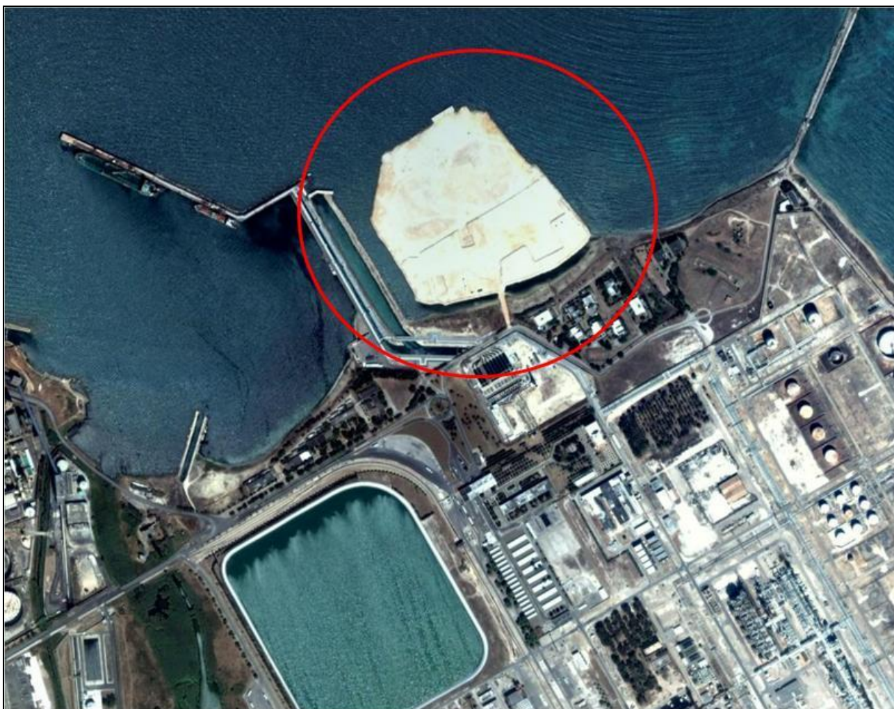
Figura 2 – Area industriale adiacente al nuovo terminal (Fonte: Google Earth)
