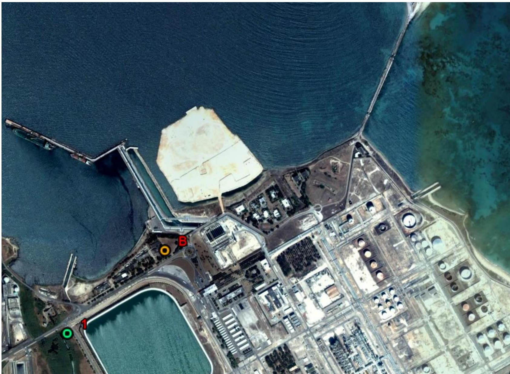
Figura 7 – Identificazione della destinazione d'uso delle aree in fase di cantierizzazione
