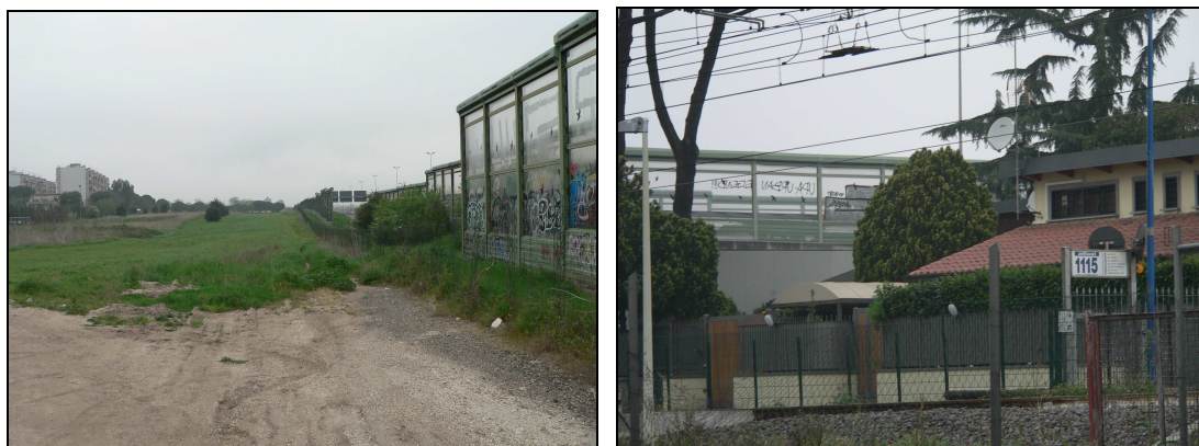
Figura 3: barriere antirumore lungo il GRA
