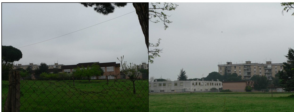
Figura 7: Complesso scolastico di via delle Alzavole, vista dall'area in cui passerà il ramo stradale RT1-RM3
