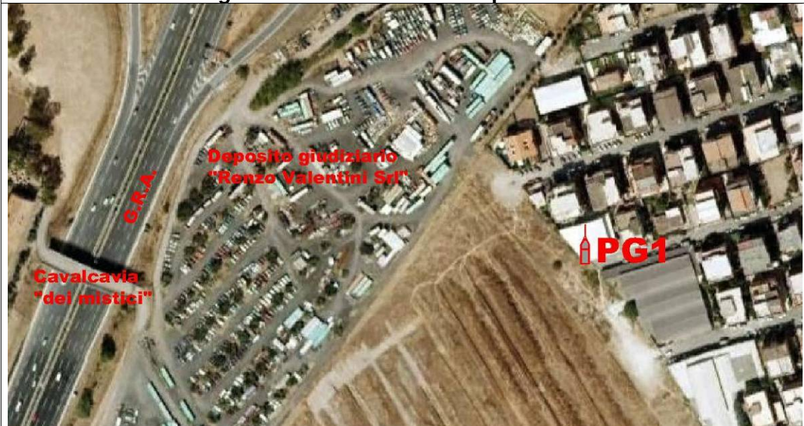
Immagine 1 – Vista aerea della postazione PG1
