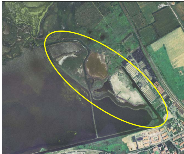
Foto aerea dell'area antistante lo stabilimento Ex SITOCO
