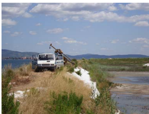
Realizzazione carotaggio A1 “Le Piane”
