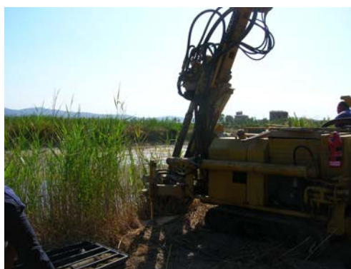
Realizzazione carotaggio A9 “Terra rossa”
